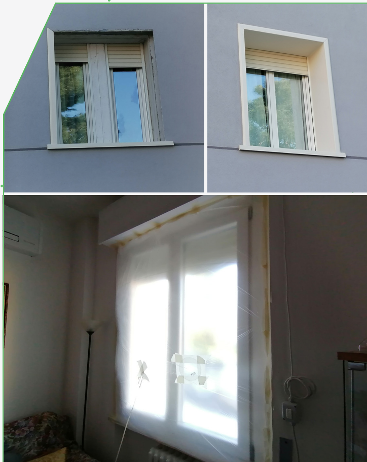
Bilder der Tests vor Ort zur Überprüfung der Luftinfiltration.
