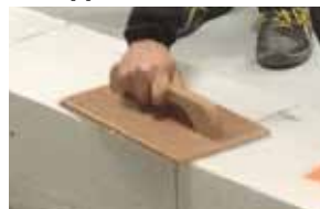
Fratteggio per levigare e ripianare
