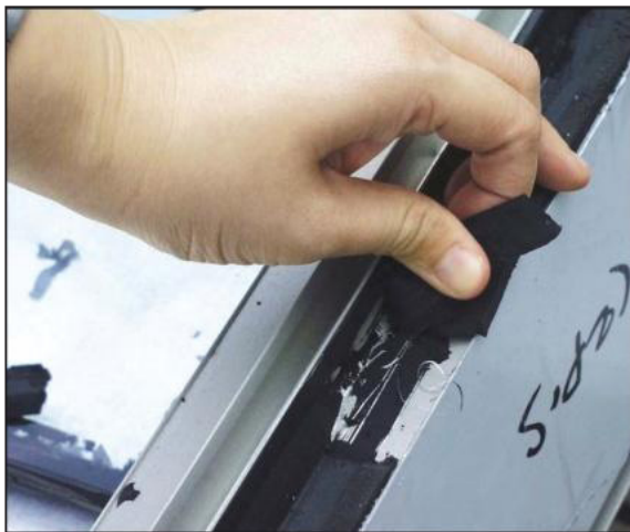
Abb. 19: Deglazing (Ausglasen)
