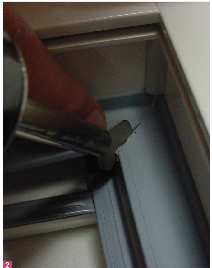
2 Die vordere Hälfte der Mitteldichtung bei 250 - 270 °C ca. 3 sec. plastifizieren.
