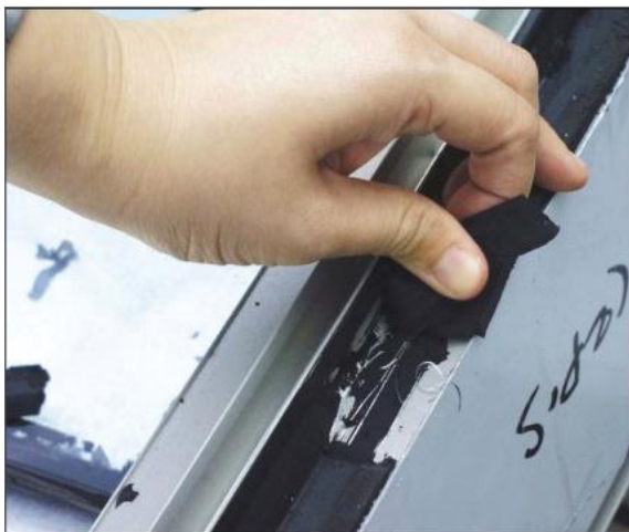
Abb. 19: Deglazing (Ausglasen)
