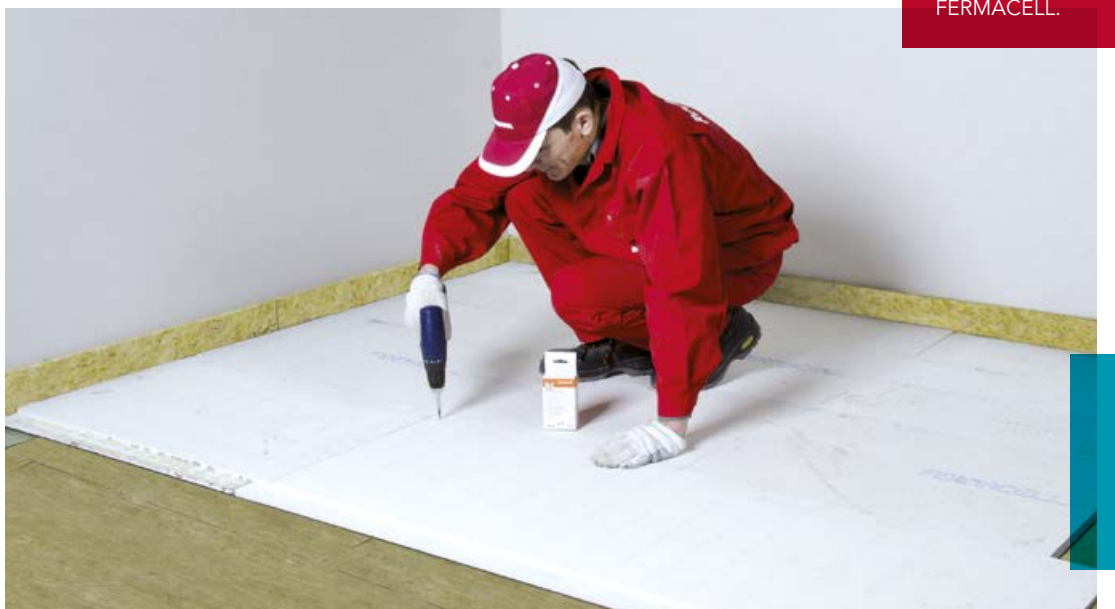
Przykładowe rozmieszczenie łączników dla płyt FERMACELL 2E22
