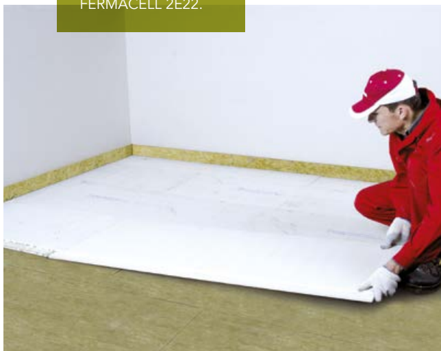
Wykonanie poszycia podłogi z płyt FERMACELL 2E22.
