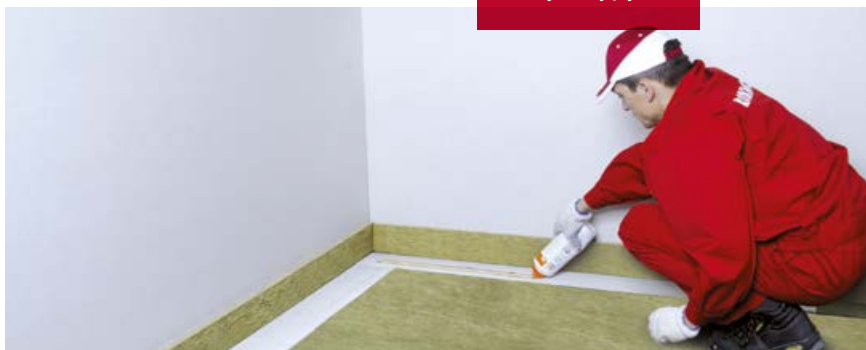
Nałożenie kleju na brzegowy pas usztyniający.
