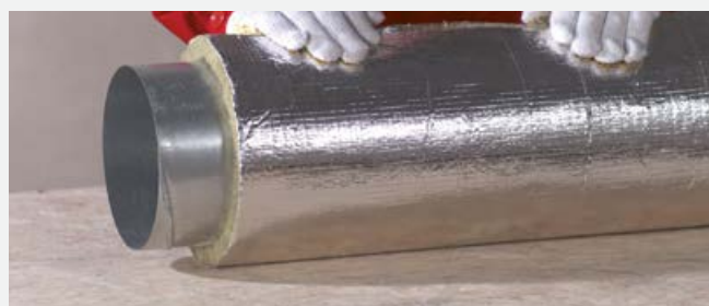
Krok 2 – owinięcie kanału izolacją.
