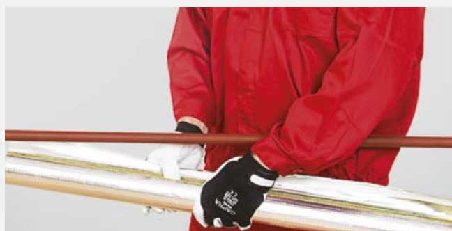
Nałożenie otuliny na odcinek prosty rurociągu.
