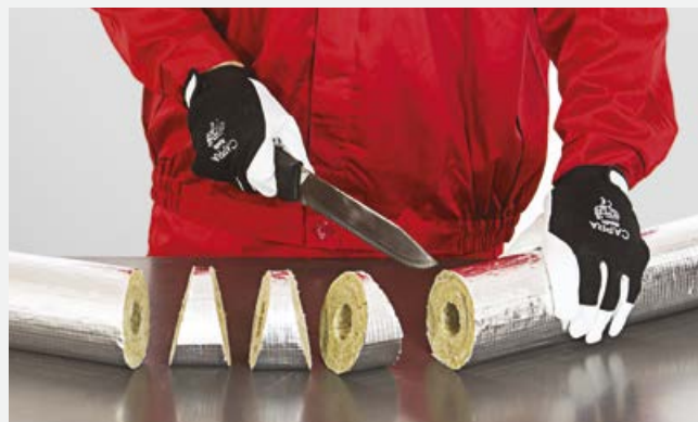
Wycinanie segmentów kolanowych.
