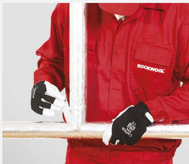
Sklejenie styków izolacji taśmą aluminiową.
