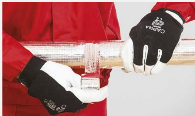
Zabezpieczenie połączenia poprzecznego otulin samoprzylepną taśmą aluminium.
