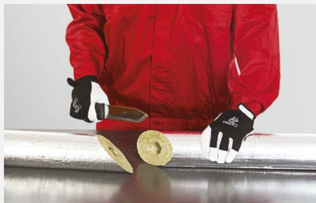
Rozcięcie otuliny pod kątem 45° na dwa elementy.
