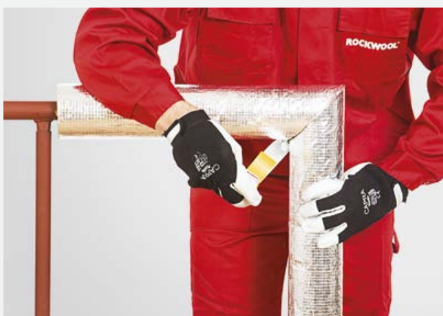
Zabezpieczenie połączenia poprzecznego otulin samoprzylepną taśmą aluminiową.
