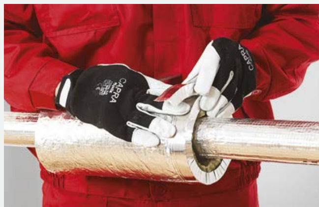
Zabezpieczenie zakończenia izolacji mankietem aluminiowym.
