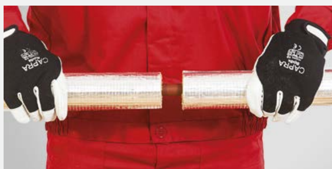
Połączenie poprzeczne dwóch odcinków otulin.
