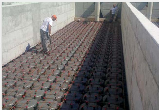
Eolo ist die effektive, schnelle und wirtschaftliche Lösung für den Bau einer Stahlbeton-Lochdecke mit hoher Tragfähigkeit, die auch von schweren Fahrzeugen befahren werden kann.
