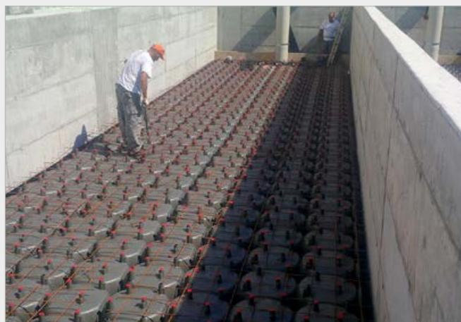
Eolo est un système de coffrages modulaires perdus facile à installer et économique pour réaliser plancher perforé pour la ventilation des plateformes de compostage, des systèmes de stabilisation des déchets et de désodorisation de l'air par biofiltration.
