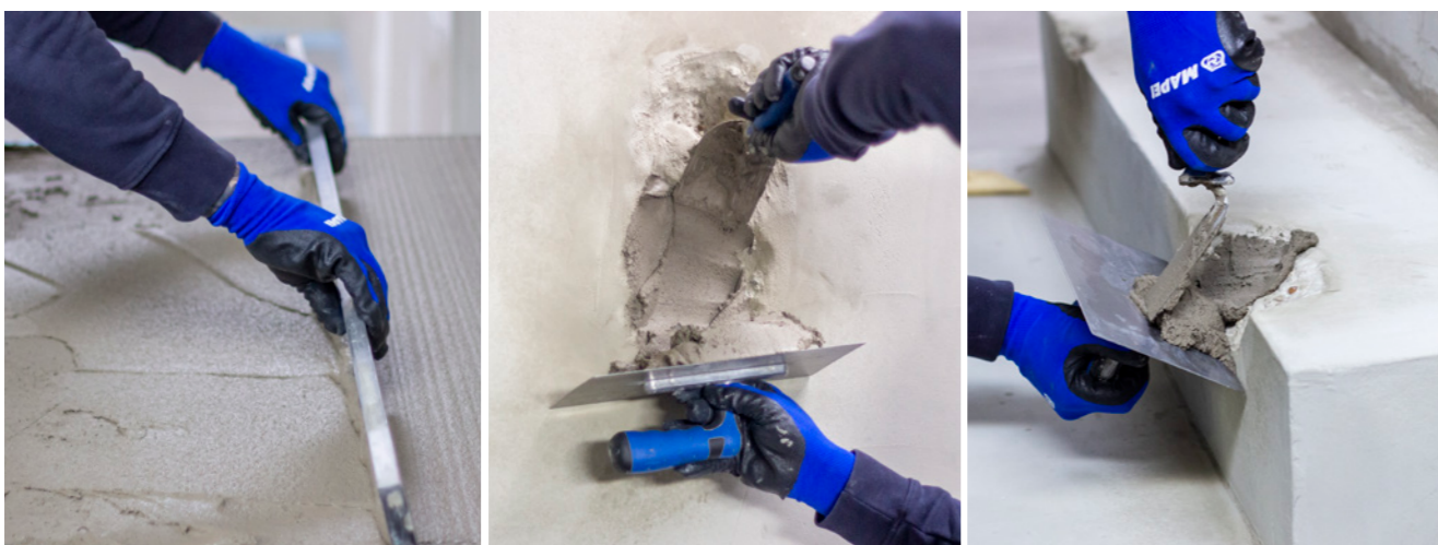
Gefälle erstellen, Ausbessern von Wandputzen, Ausbessern von Ausbrüchen an Treppen
