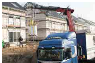
Kran-LKW: Bei der Anlieferung mit einem Kran-LKW wird die Ware punktgenau abgesetzt.
