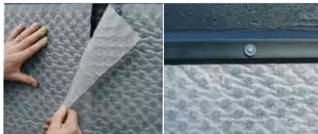
Recouvrement de Fonda GTX
