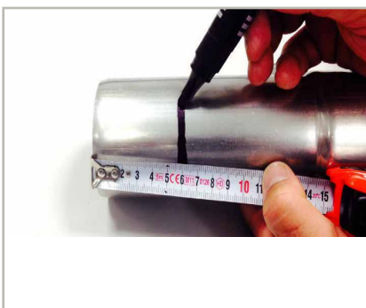
Figura 4 Marcado del accesorio. Marking the insertion's depth.
