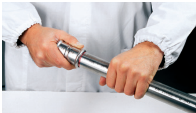
Inserción del tubo en el accesorio de prensar
