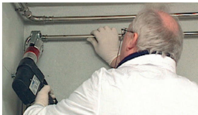
Prensado de la unión
