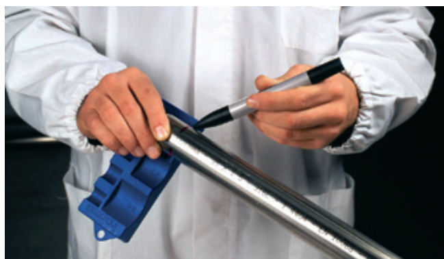
Marcar la profundidad de inserción
