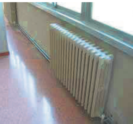
Fig. 16 - Instalación de calefacción por radiador.
