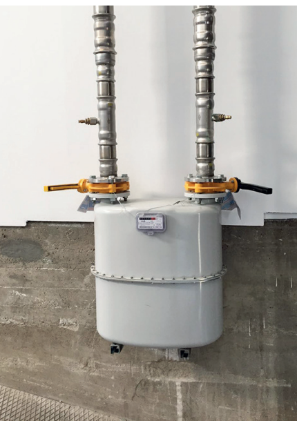
Fig. 21 - Instalación gas en nave industrial
