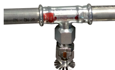
Fig. 19 - Instalación de splinkers contra incendios vía húmeda.
