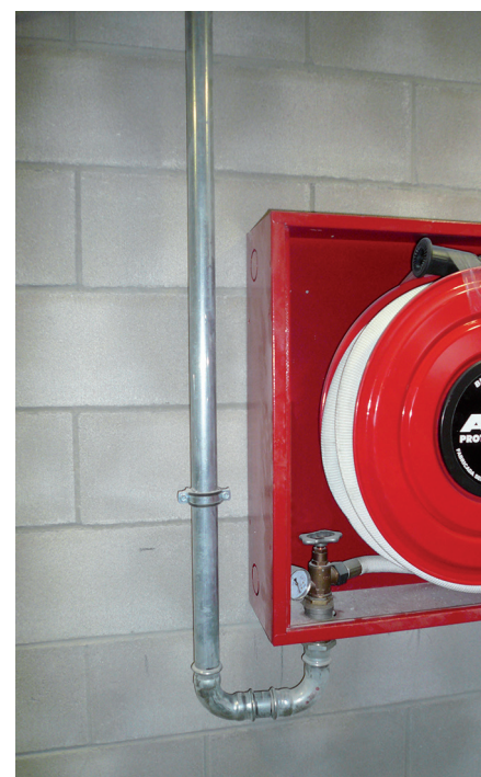
Fig. 17 - 18 Instalación de BIE's contra incendios.
