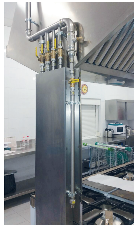
Fig. 24 - Instalación gas en cocina.
