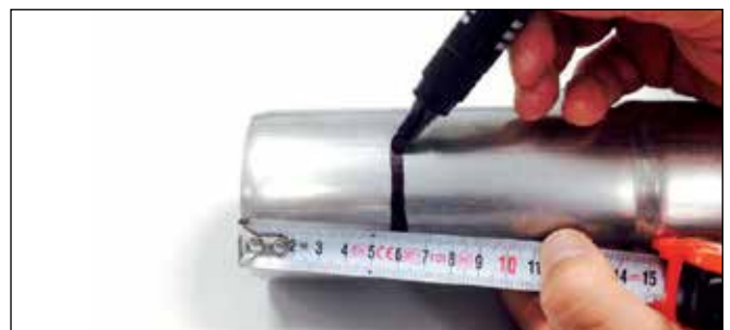
Figura 5 – Markierung der Einsattiefe
