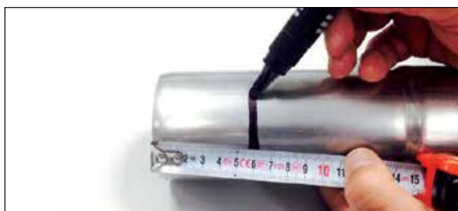
Figura 5 - Marcatura quota d'innesto
