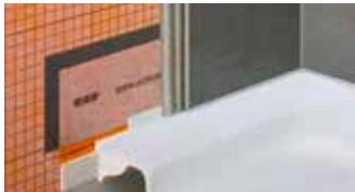
Schlüter-KERDI-TS ist ein Set zur sicheren Abdichtung von Einbauteilen wie z. B. Bade- und Duschwannen (gemäß DIN 18534-1) an das Schlüter-KERDI Abdichtungssystem. Es beinhaltet einen Anschluss-Dichtband aus Polyethylen mit beidseitigem Vliesgewebe und selbstklebendem Schalldämmstreifen, Schlüter-KERDI-FIX Montagekleber, Reinigungstücher sowie Montageecken. (Produktdatenblatt 8.9)
