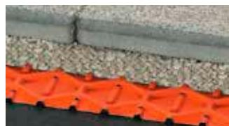
Schlüter-TROBA ist eine Trenn- und Drainageschicht über horizontalen Abdichtungen unter Estrich- oder Kiesauflagen. Sie besteht aus einer druckstabilen Polyethylen-Noppenfolie mit Löchern zu den Drainagekanälen. Zur Fliesenverlegung auf Estrichschichten muss als Entkopplung und Abdichtung Schlüter-DITRA 25 eingebaut werden. (Produktdatenblatt 7.1)
