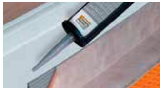
Schlüter-KERDI-FIX ist ein elastischer Montagekleber auf der Basis eines MS-Polymer. Es eignet sich zum Verkleben von Profilen und Schlüter-KERDI-BOARD sowie zum Abdichten von Anschlüssen mit Schlüter-KERDI.
