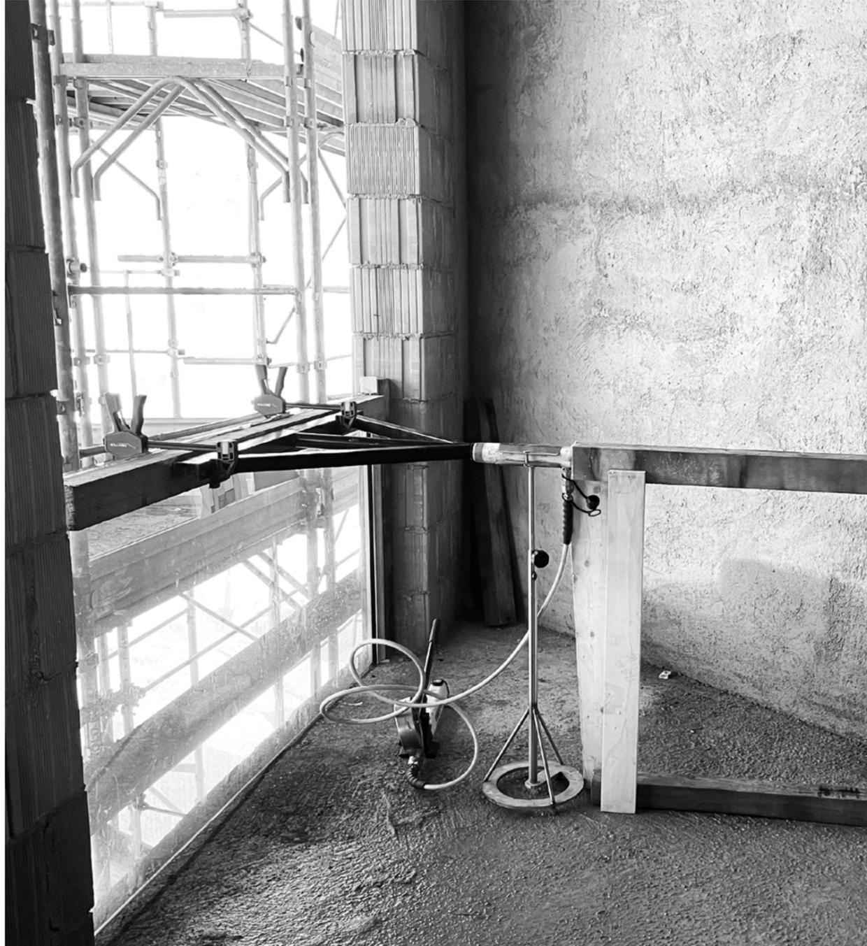
In questa foto vediamo un test in cantiere con il fissaggio effettuato sul lato interno della muratura in laterizio. In questo caso il progettista ha fatto riempire i singoli blocchi con malta cementizia, poi il fissaggio del profilo in alluminio è avvenuto con delle astine filettate da 180 mm e resina Vinilistere.
