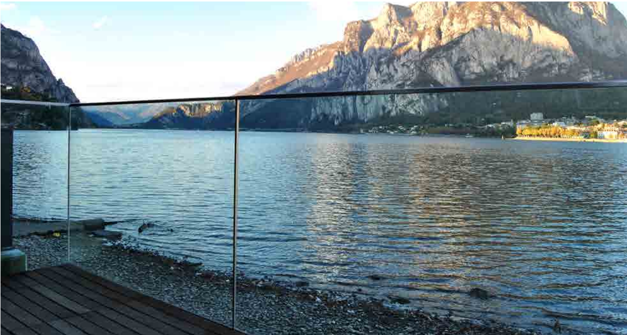
Réaménagement du front de lac de Malgrate, Malgrate (LC), IT. Partner: Vetreria Colombo
