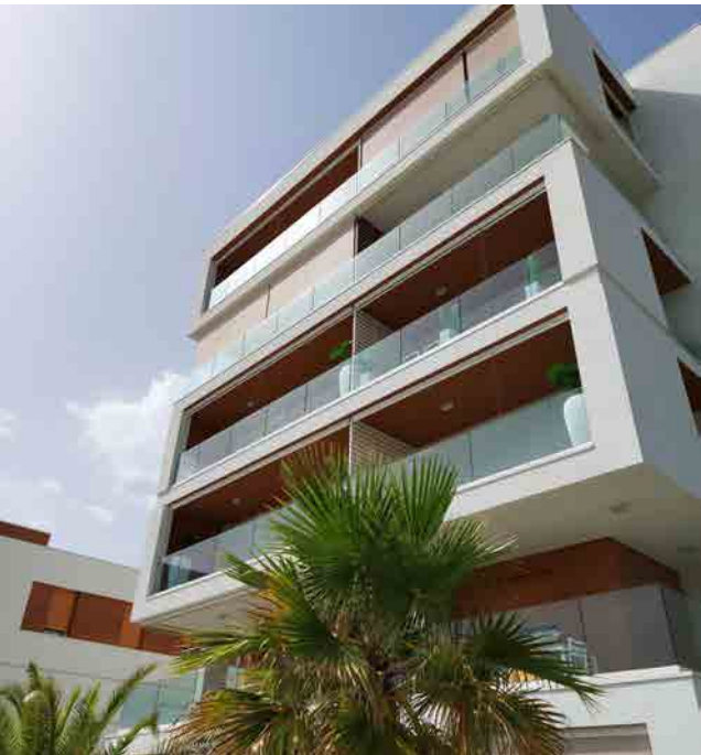
Immeuble résidentiel à Jesolo, IT
