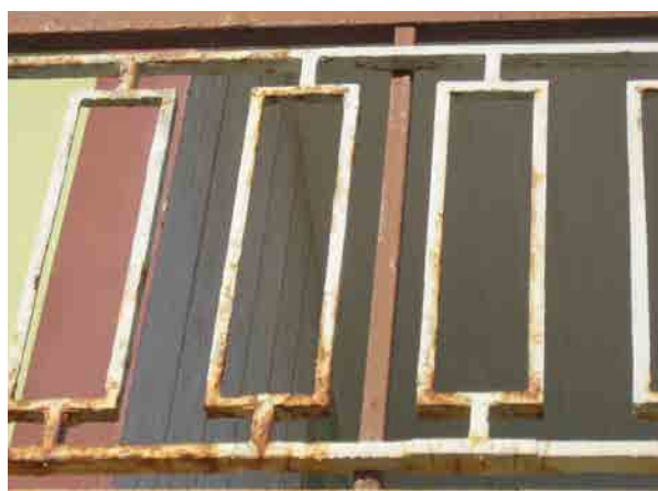
Entretien avec des traitements anti-rouille spécifiques pour les garde-corps métalliques courants, pour éviter qu'ils ne soient corrodés par le temps, perdant beauté et sécurité.
