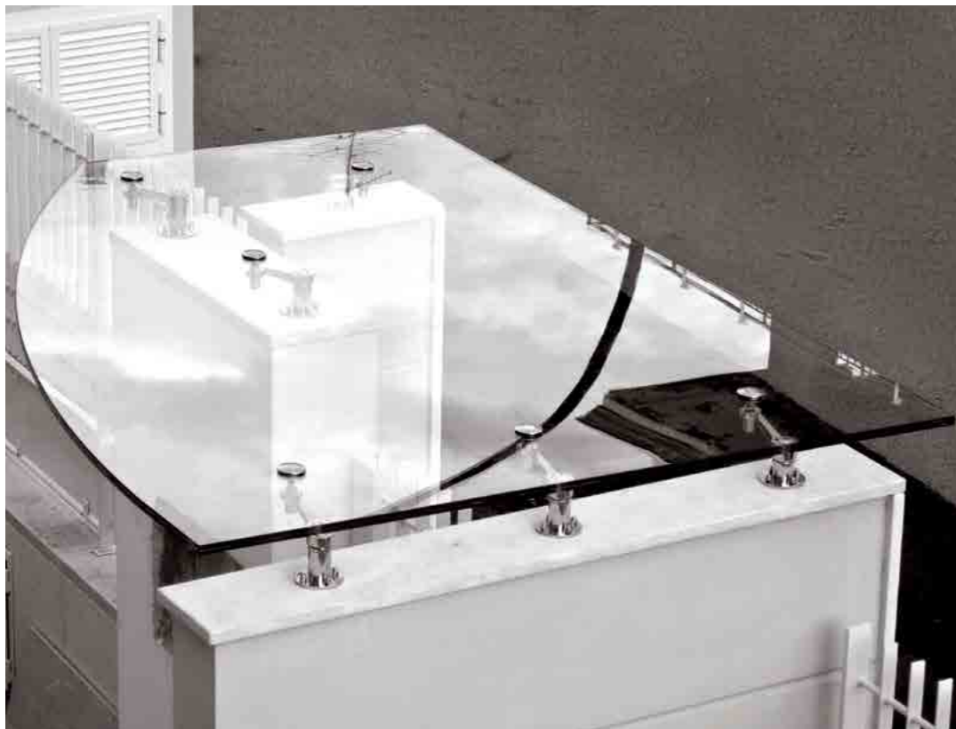
Entrance gate covering. / Couverture du portail d'entrée.
