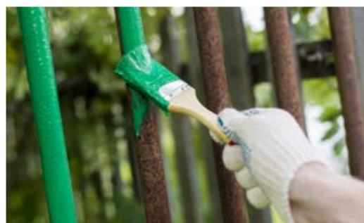
Un entretien avec des traitements antirouille spécifiques pour les garde-corps métalliques communs est recommandé, pour éviter qu'ils ne soient corrodés par le temps, perdant beauté et sécurité.
