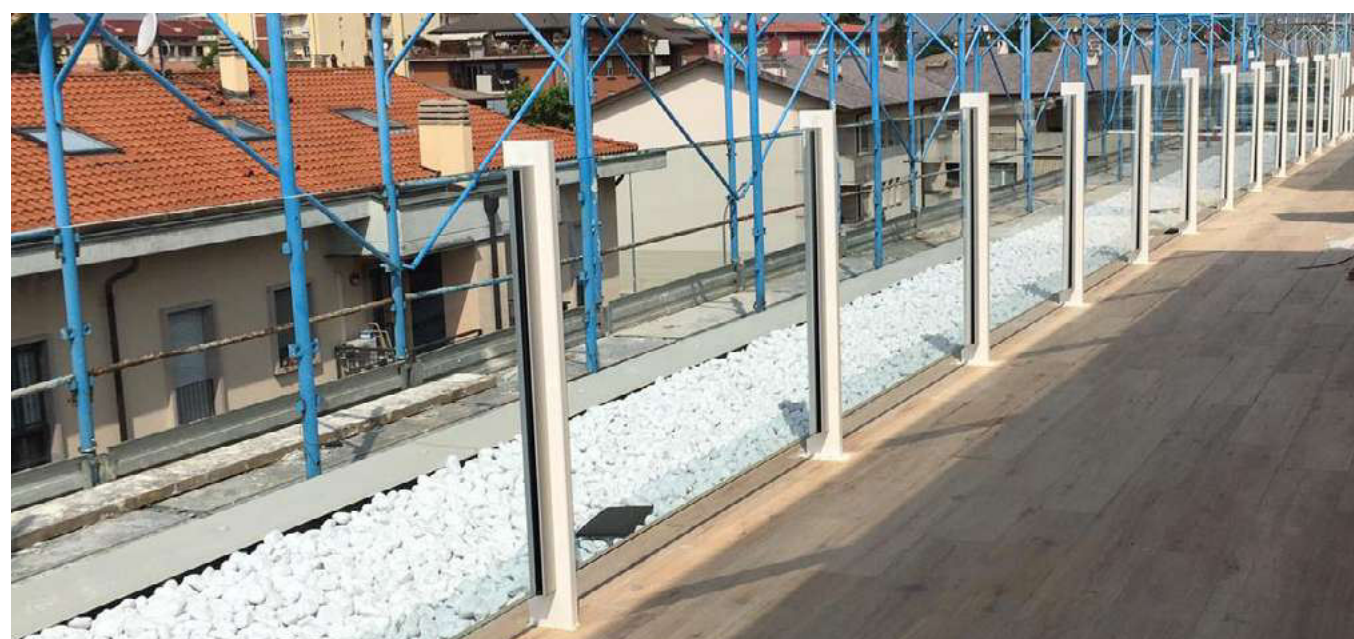
Terrasse avec système Giulietta terminée
