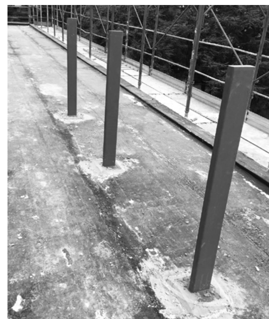
Image du chantier de construction avant l'installation de Giulietta
