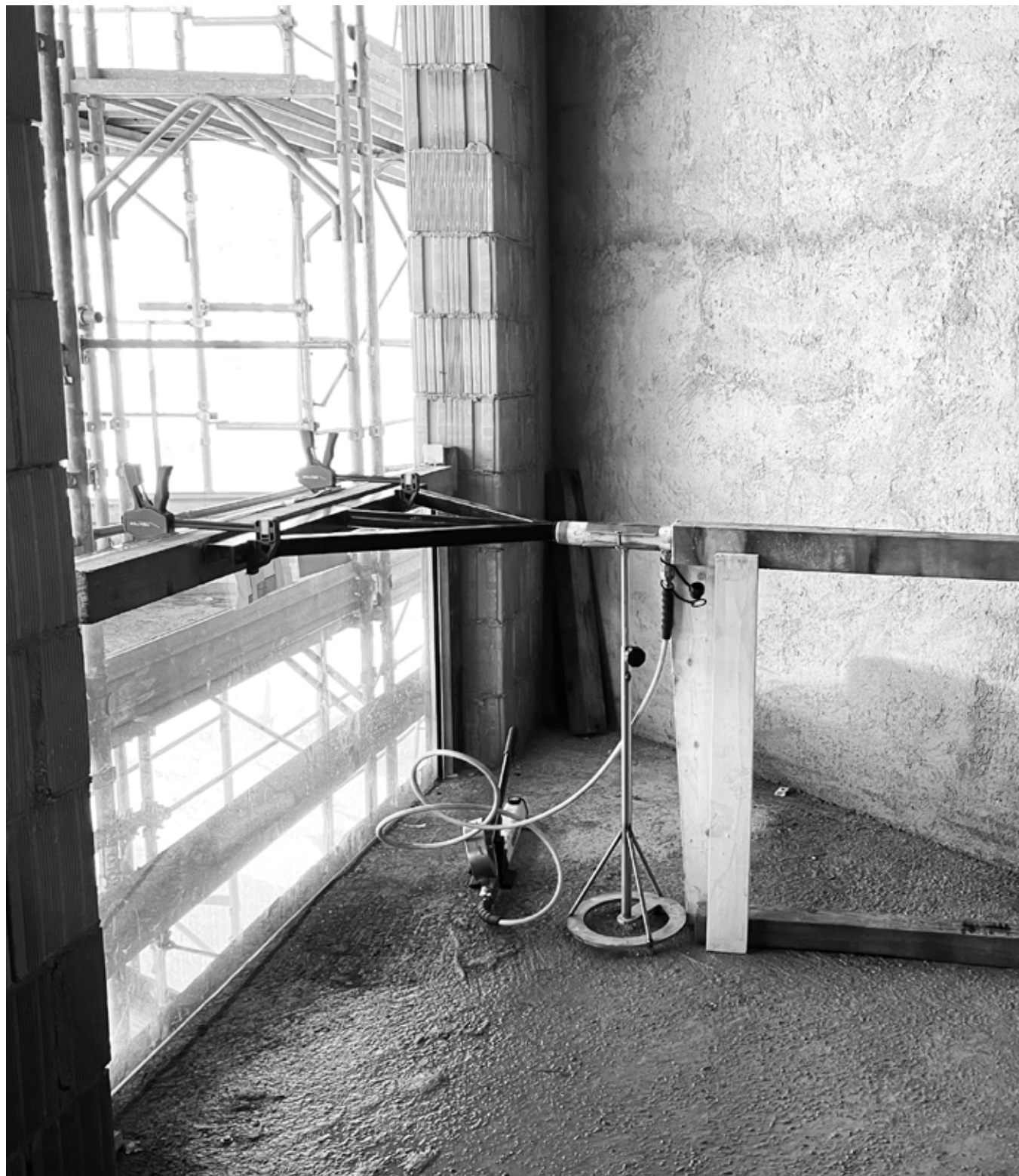
Esempio di test in cantiere con prove di spinta fino a 300 kg/m con un vetro 10+10 da 250 cm di larghezza per 110 cm di altezza, con esito totalmente positivo.
