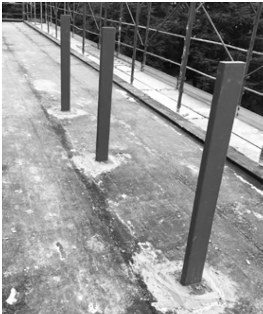
Immagine di cantiere prima dell'installazione di Giulietta
