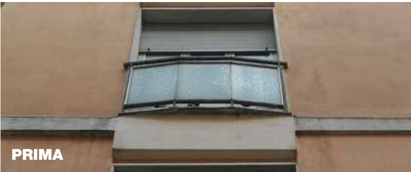
Esempio di un edificio con balconi alla francese non a norma con vetri retinati.
