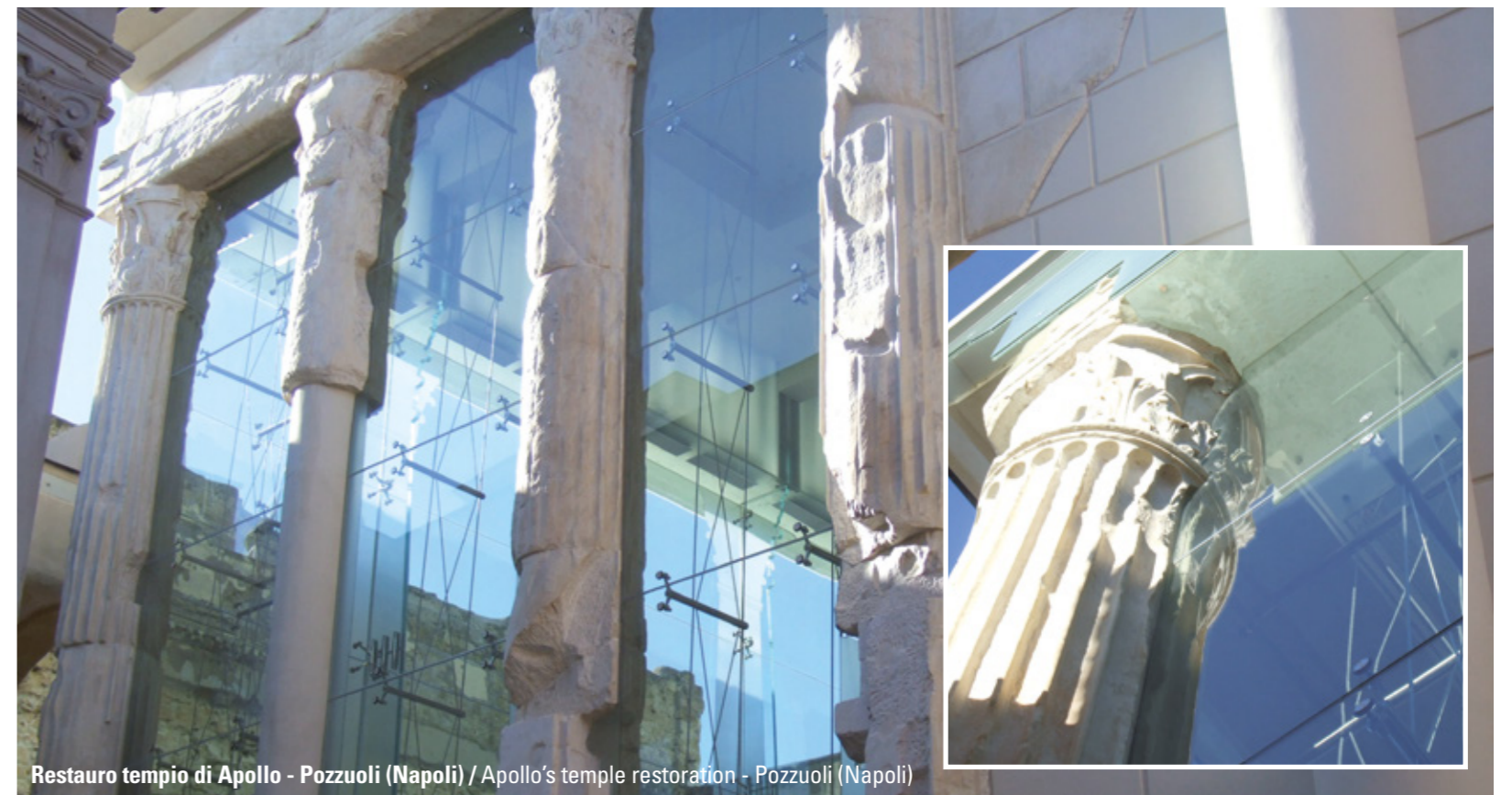
Restauro tempio di Apollo - Pozzuoli (Napoli) / Apollo's temple restoration - Pozzuoli (Napoli)
