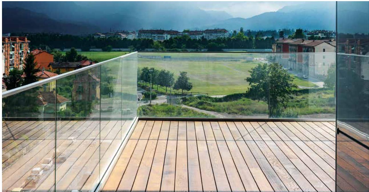
Edificio Polifunzionale, Cuneo, IT
