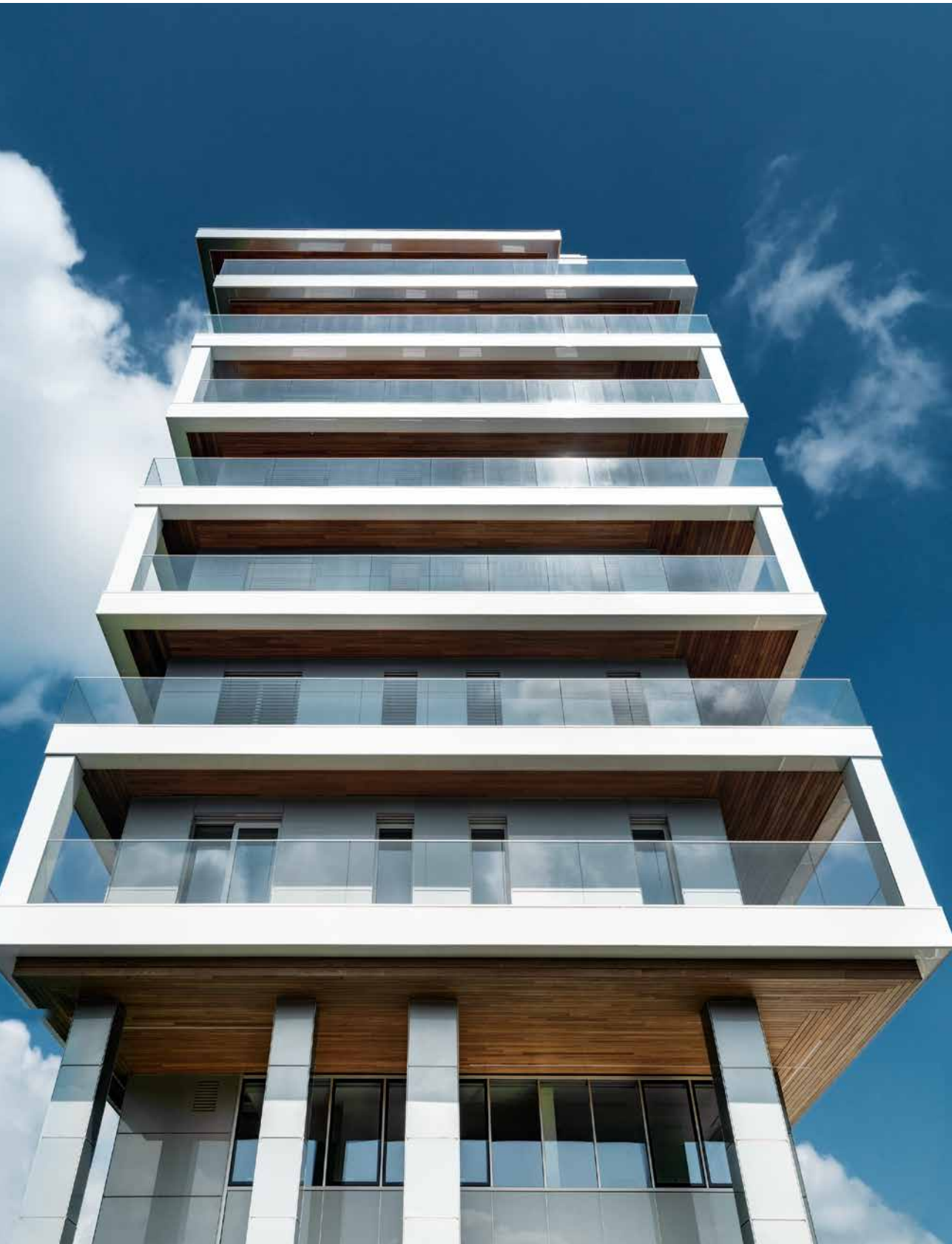
Edificio Polifunzionale, Cuneo, IT
