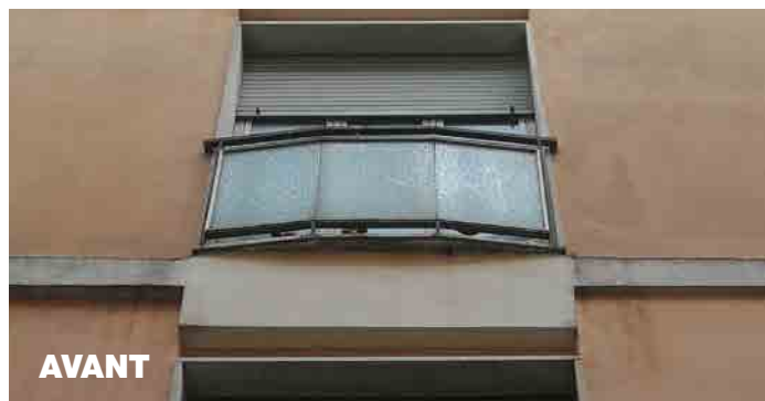
Exemple d'un bâtiment avec des balcons à la française non aux normes en verre armé.
