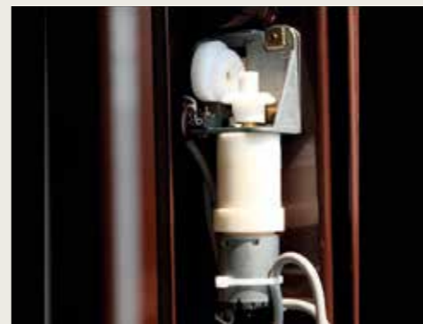
SCROCCO ELETTRICO GÂCHE ÉLECTRIQUE
