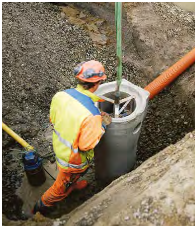
Montage av DRB brunnar.
