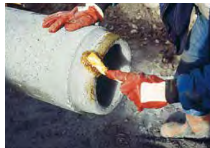
3. Smörj spetsen runt om med Forsheda Lub. Var extra noga med den främre runda delen.
