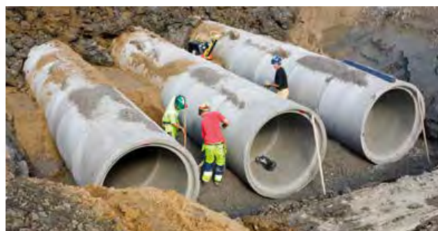
Installation av dagvattenmagasin
