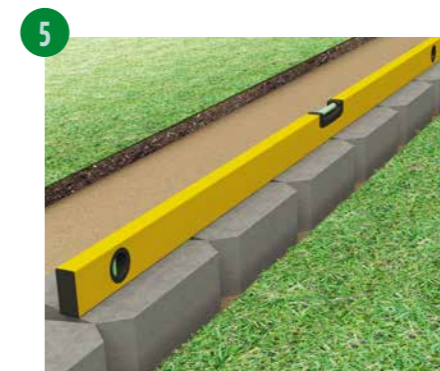
5 Kontrollera med vattenpass att alla block ligger horisontellt.
