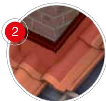
Pour résoudre correctement les rencontres avec des parements et cheminées, on utilisera les bandes d'étanchéité à usages multiples (Premium ou Aluminium). Dès que ces bandes adhéreront au parement propre et sec, il faudra terminer le travail en posant la ligne d'égoût et en scellant la ligne supérieure au moyen d'un cordon continu de mastic.
