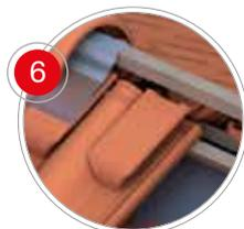
Le liteau qui est installé sur le faîtage sera fixé aux supports de liteau. Pour l'installer, il faudra le fixer au support en veillant à ce que la pente et la hauteur permettent aux faîtières de rester directement appuyées sur les tuiles de la dernière rangée et sur les sous-faîtières.
