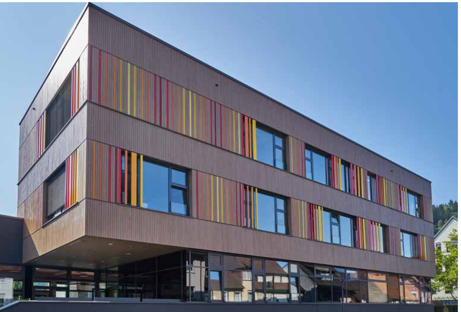
Bsp. Weißtanne Proteco25 (mocopinus) + Brandschutzimprägnierung B1 Firesec
