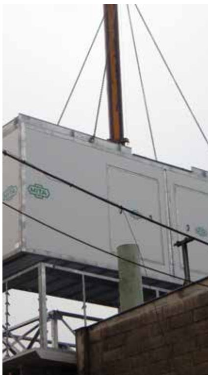
Accompagnamento durante l'installazione.
