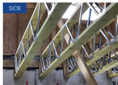
Surélévation - Appui sur membrure haute
