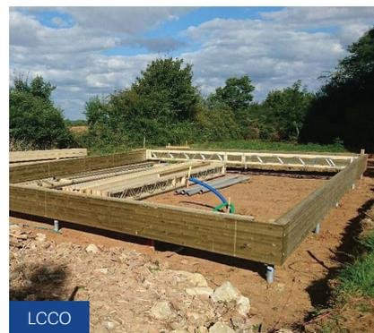
Plancher rez-de-chaussée sur pieux
