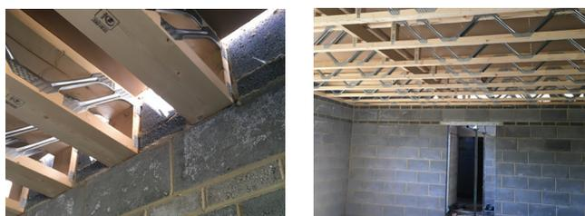
**Poutre POSI® encastrée - appui sur membrure basse**
