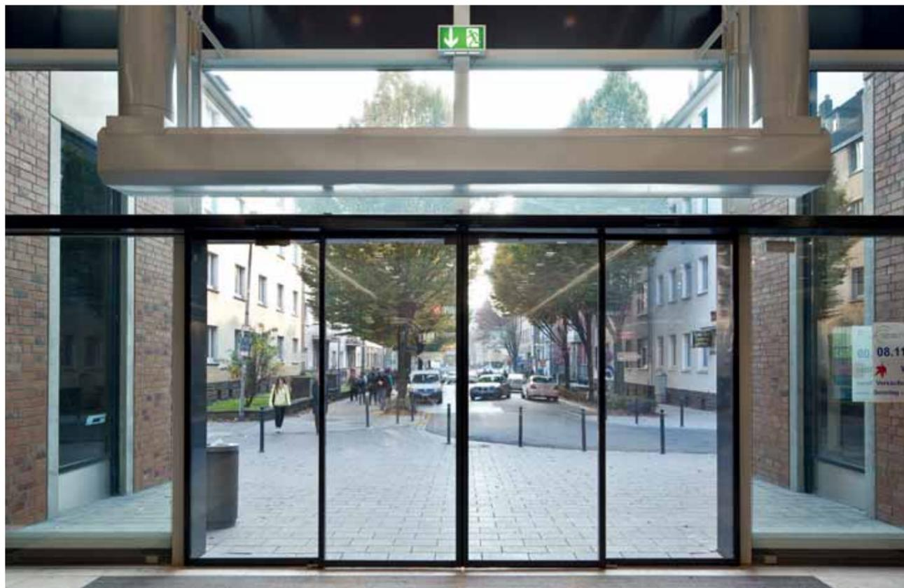
La porte automatique antipanique intégrale ressemble à une porte automatique standard avec des profils étroits (FLEX). En cas d'évacuation d'urgence, les usagers peuvent ouvrir manuellement les vantaux et laisser ainsi une largeur de passage maximale (fonction break out) rendant ainsi l'évacuation facile. En mode automatique, la porte fonctionne comme une porte coulissante standard.
