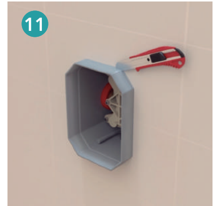
11 Realizar el corte del perfil sobrante de la caja iClever. Instalación de la caja iClever finalizada. Cut the excess profile of the iClever box. Installation of iClever box completed. Couper la partie excédentaire du profil du boîtier iClever. L'installation de l'iClever est terminée. Corte o perfil em excesso da caixa de iClever. Instalação da caixa iClever concluída.
