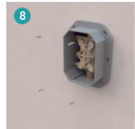
Fijar la caja iclever mediante tornillos. Fix the iclever box with the screws / Fixer le boîtier iclever avec des vis. / Fixe a caixa do iclever com parafusos
