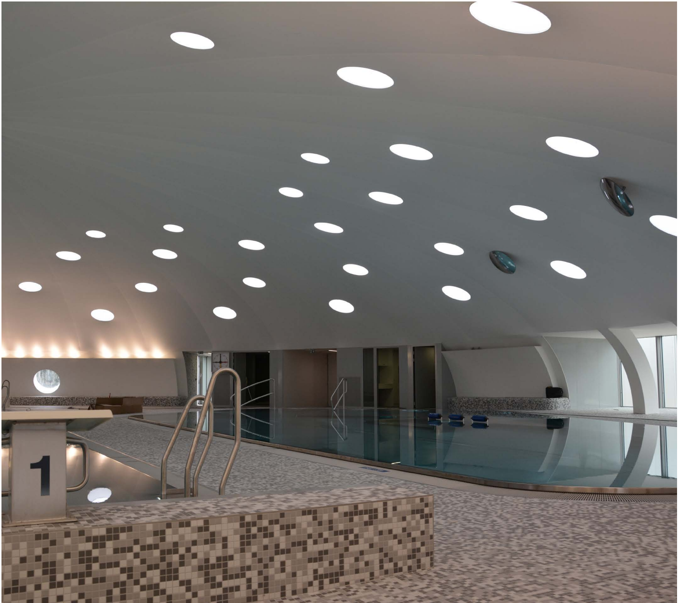
Piscine de Lingolsheim - FRANCE Plafond acoustique - Installation : VLB (Voltaire Louis et la Bergère)
