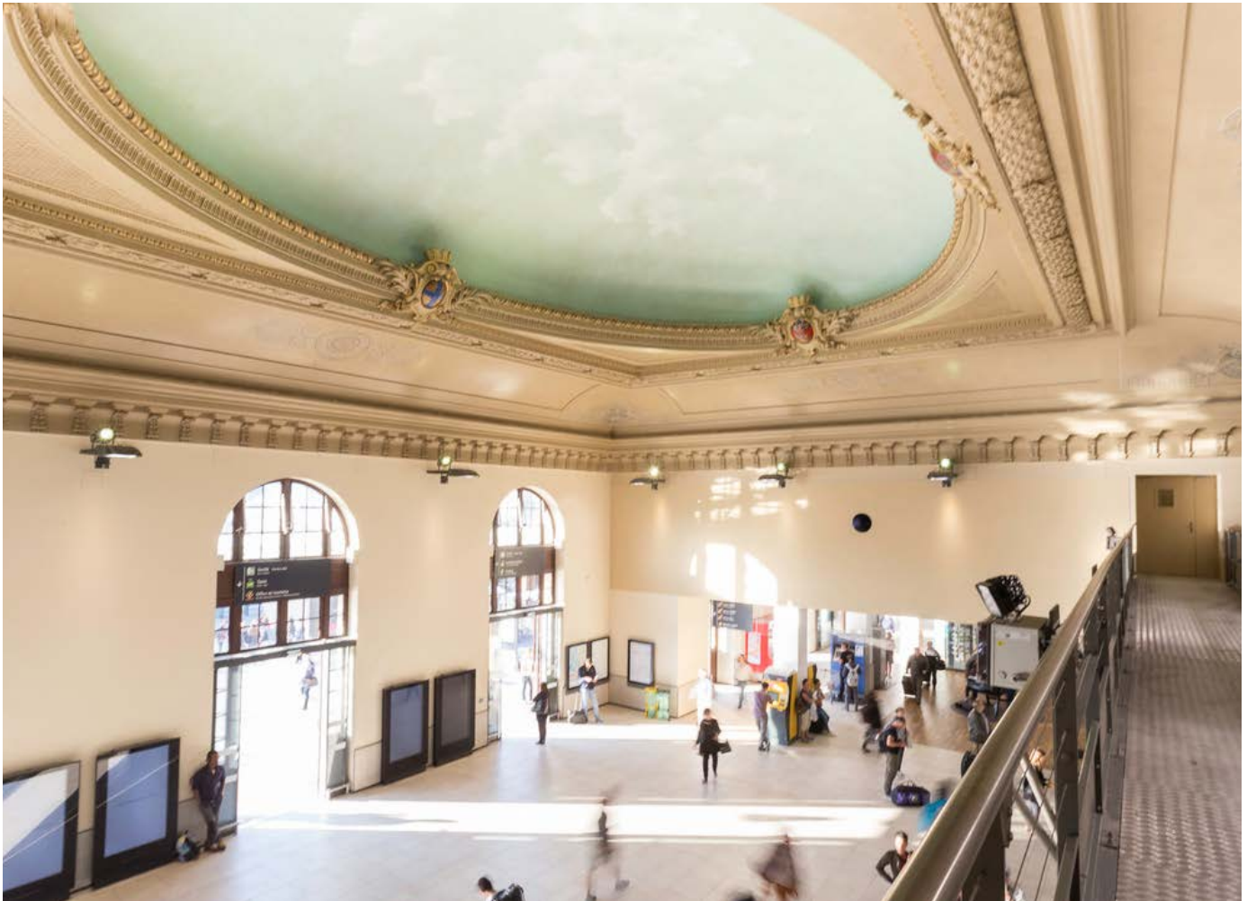
Gare de Nice - FRANCE Murs acoustiques couleur «Paille» - Installation : CLIBAT
