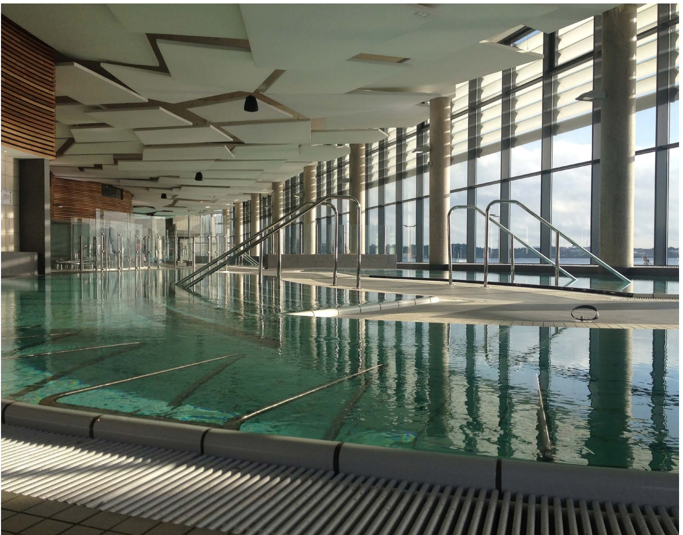
Les thermes de Ballaruc - FRANCE Cadres et formes acoustiques sur-mesure - Installation : TELIA
