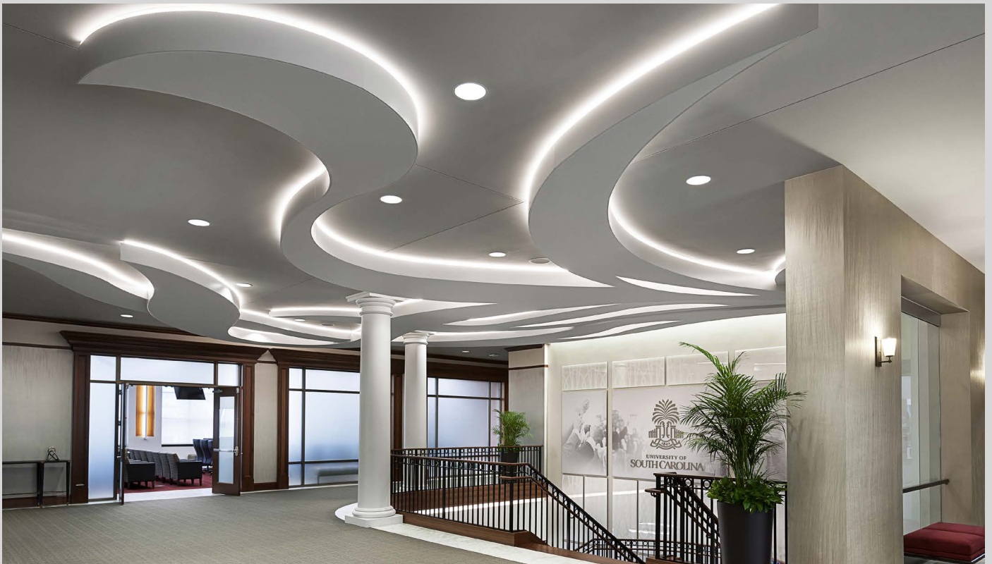
Université de Caroline du Sud - USA Plafond structuré acoustique blanc avec intégration de lumière - Architecte : L3SP - Installation : Warco Constructions Inc.
