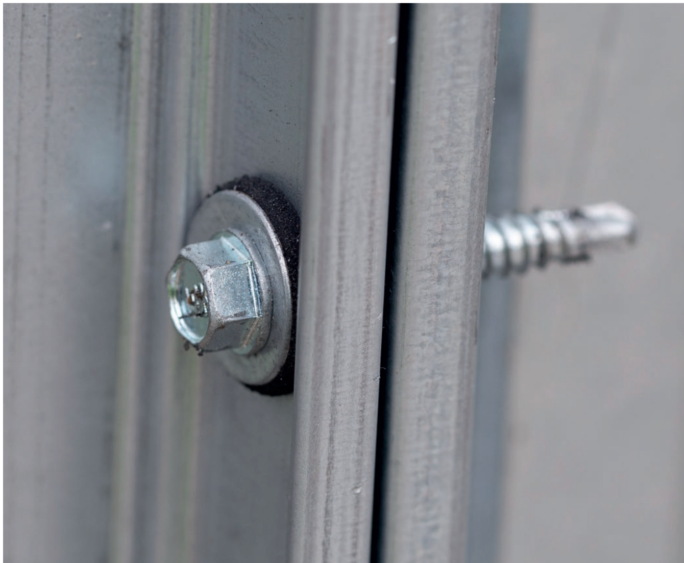
Połączenie blach stalowych
