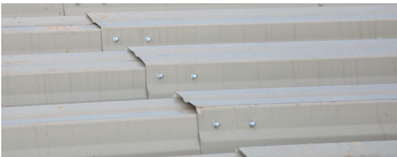
Szycie blach trapezowych na zakładzie
