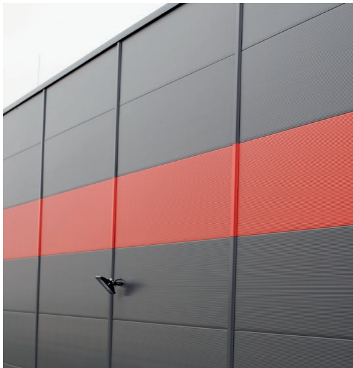
Zamocowanie obróbki blaszanej
