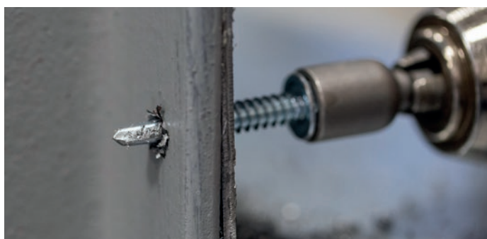
Mocowanie profilu zimnogiętego do konstrukcji nośnej ściany wykonanej z dwuteownika
