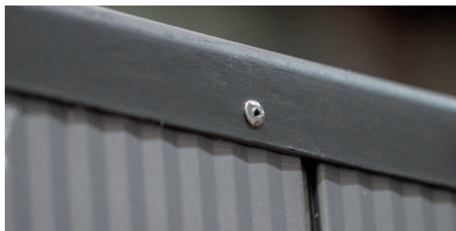
Zamocowanie obróbki blacharskiej
