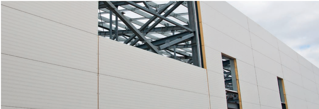
Montaż ściennych płyt warstwowych
