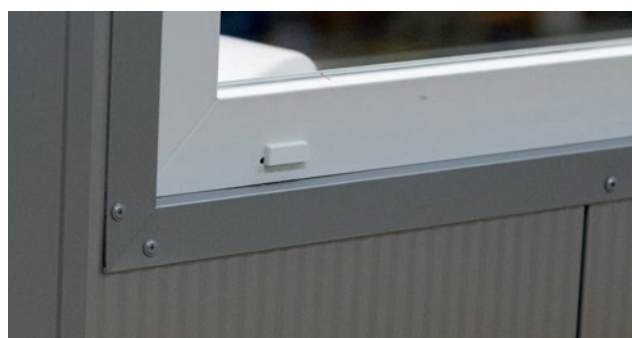
Zamocowana obróbka okna do płyty warstwowej
