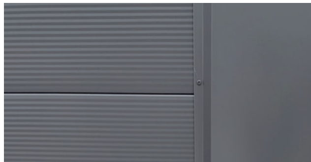
Zamocowana obróbka narożna ściany z płyt warstwowych
