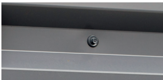
Montaż blachy trapezowej do konstrukcji stalowej
