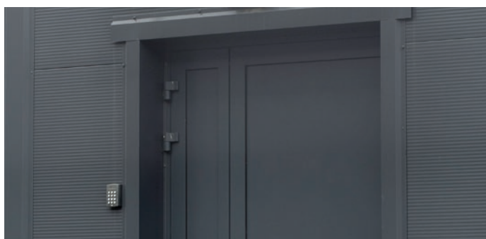
Zamocowane obróbki wokół drzwi wejściowych
