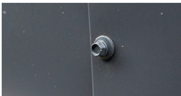
Szycie blach na zakład
