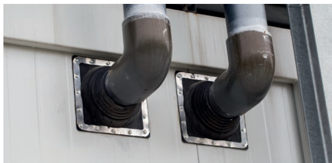
Zamocowanie uszczelnienia przebicia ściany
