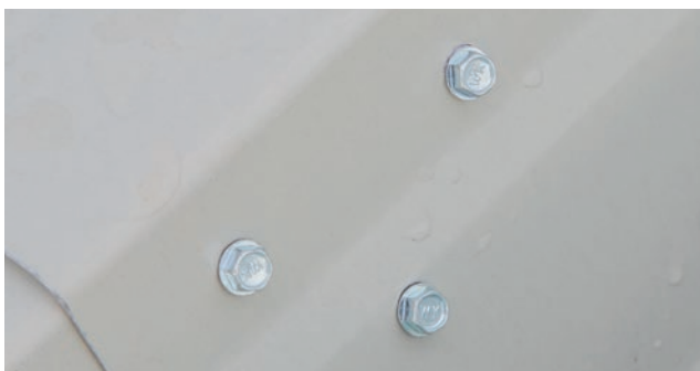
Szycie blach na zakład
