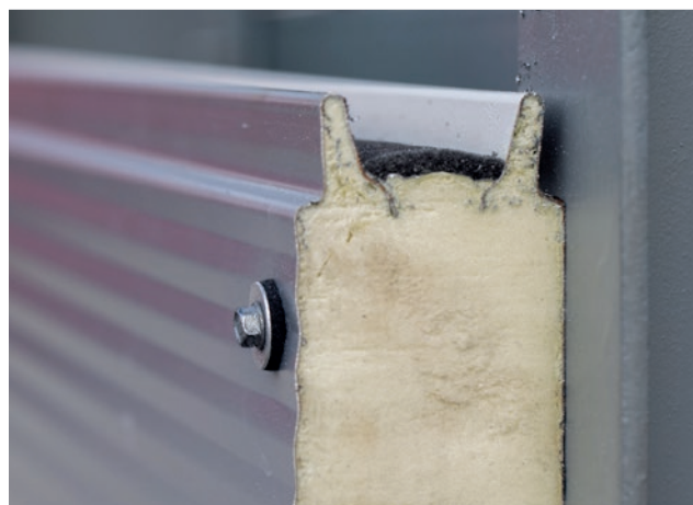
Zamocowana ścienna płyta warstwowa do konstrukcji nośnej
