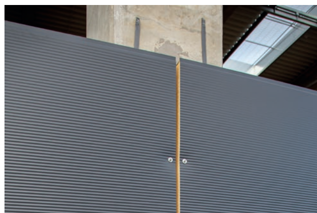
Zamocowana ścienna płyta warstwowa do podłoża betonowego
