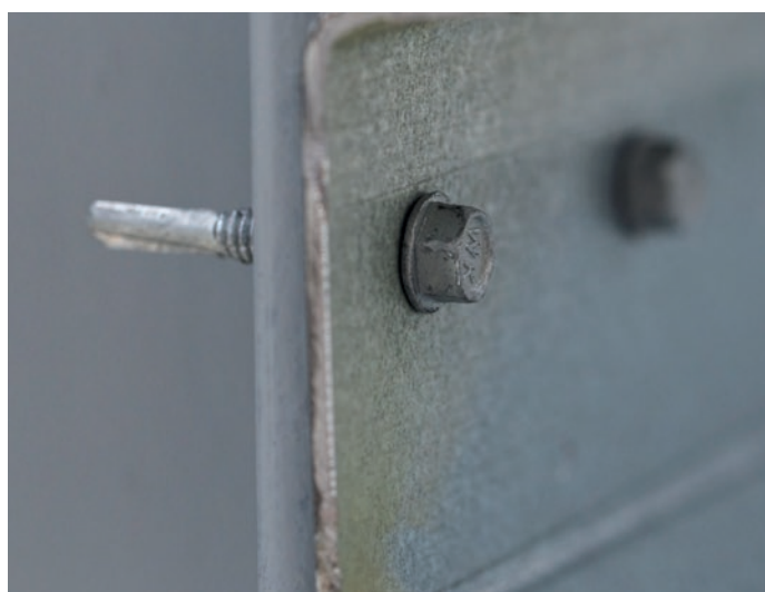
Montaż podkonstrukcji do konstrukcji nośnej ściany
