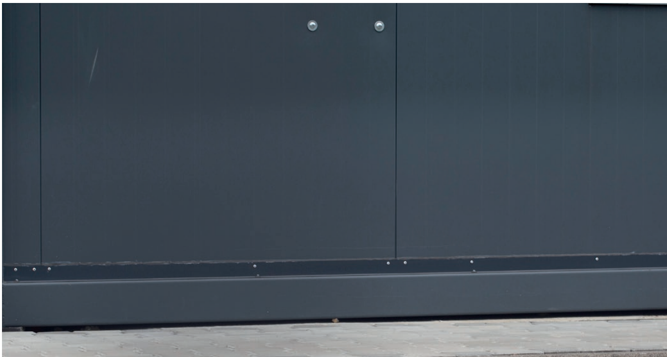
Zamocowanie obróbki kontenera
