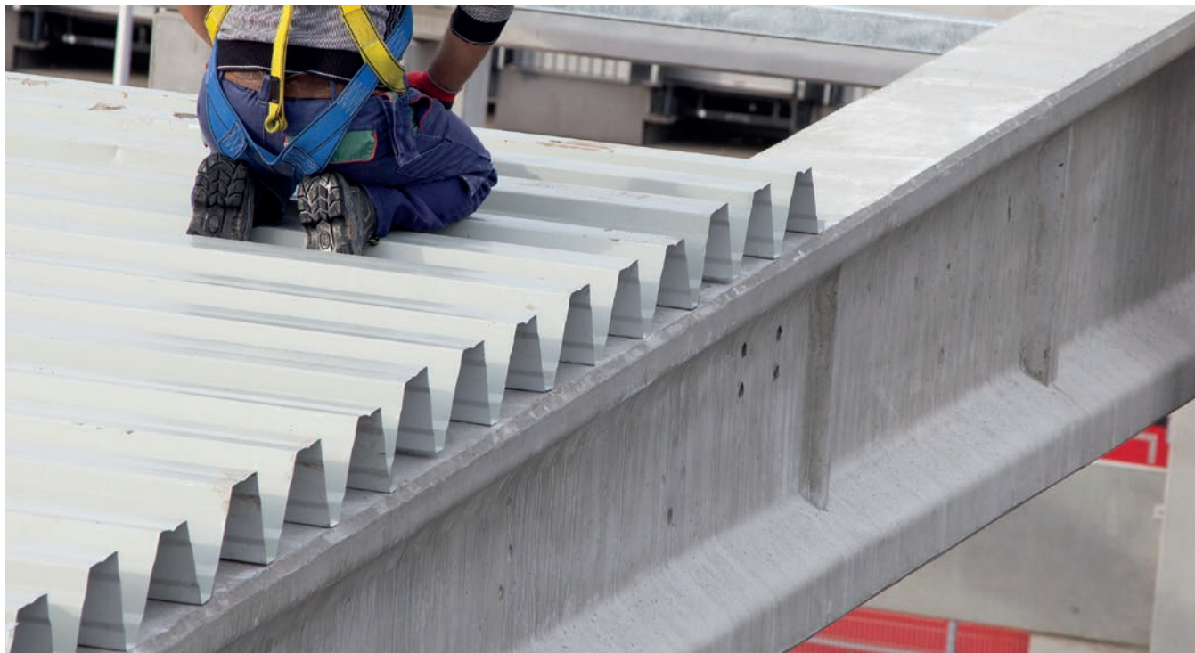
Mocowanie blachy trapezowej do betonowej konstrukcji nośnej dachu
