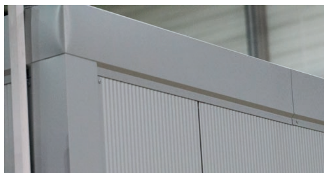
Zamocowanie obróbki blacharskiej
