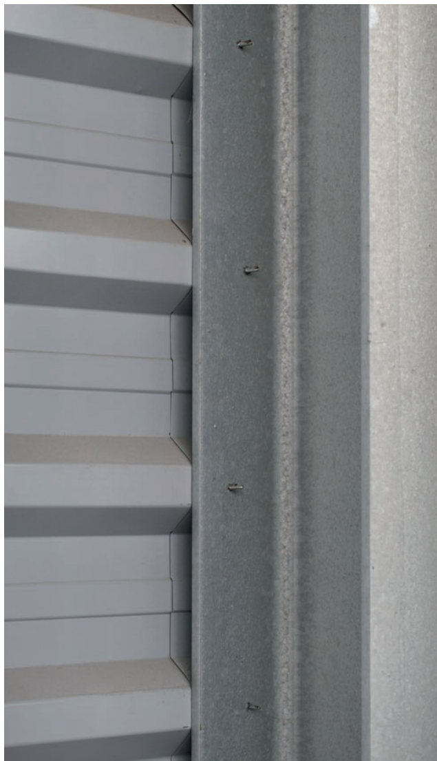
Zamocowana osłonowa blacha trapezowa do konstrukcji stalowej
