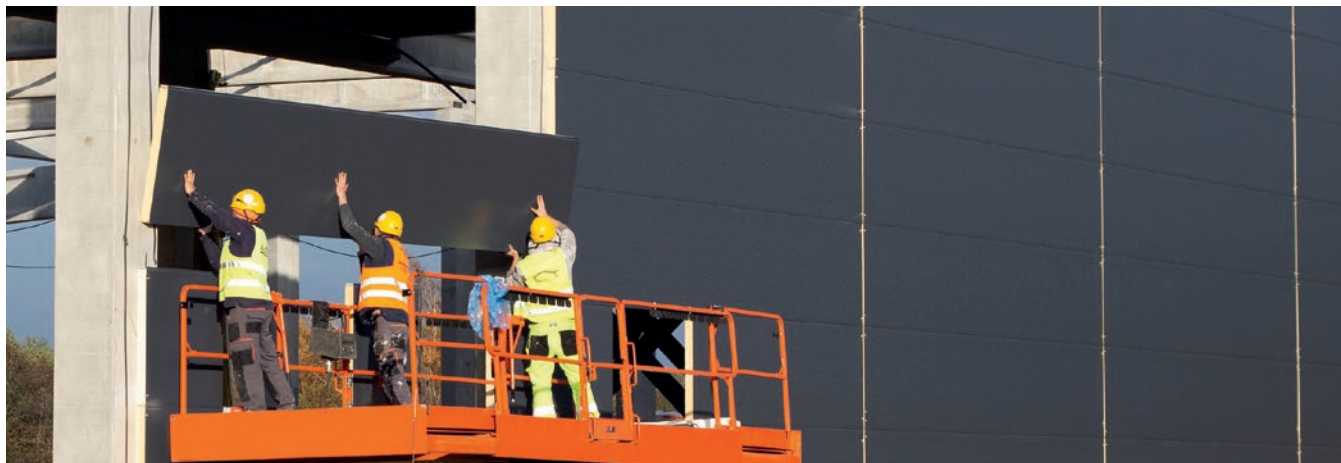
Montaż ściennych płyt warstwowych do słupów betonowych
