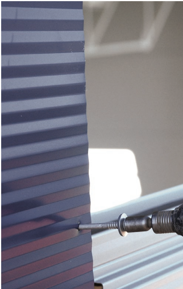
Montaż ściennych płyt warstwowych do podkonstrukcji stalowej
