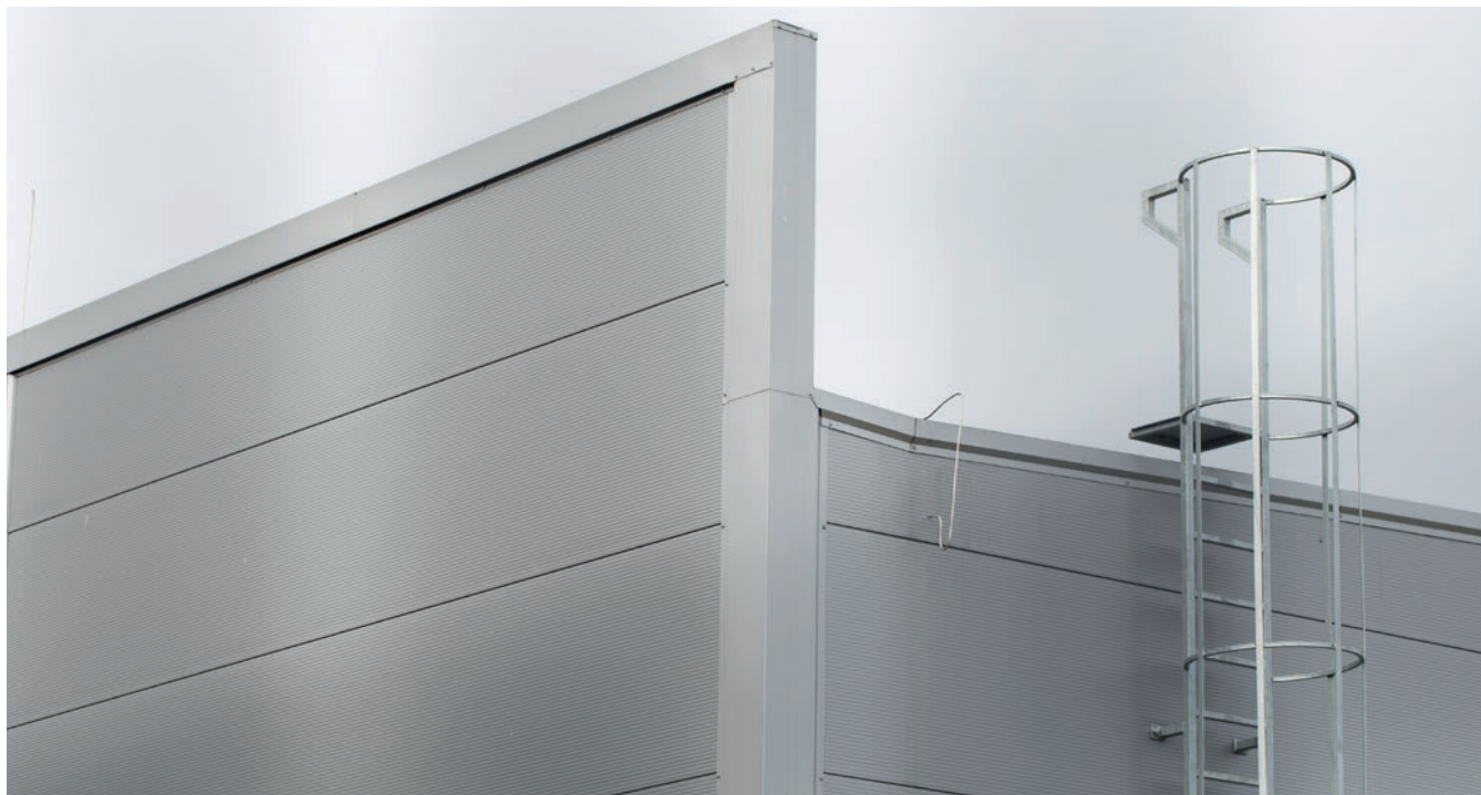
Zamocowanie obróbki attyki oraz narożnika ściany
