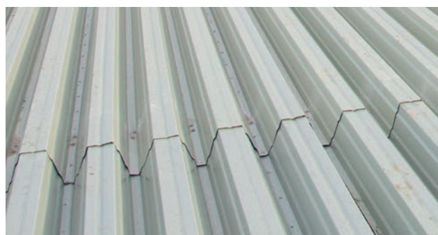
Mocowanie blachy trapezowej do podkonstrukcji stalowej
