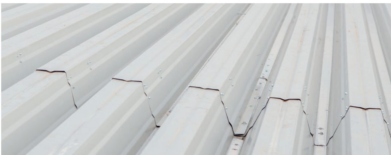
Zamocowanie blachy trapezowej do stalowej konstrukcji dachu
