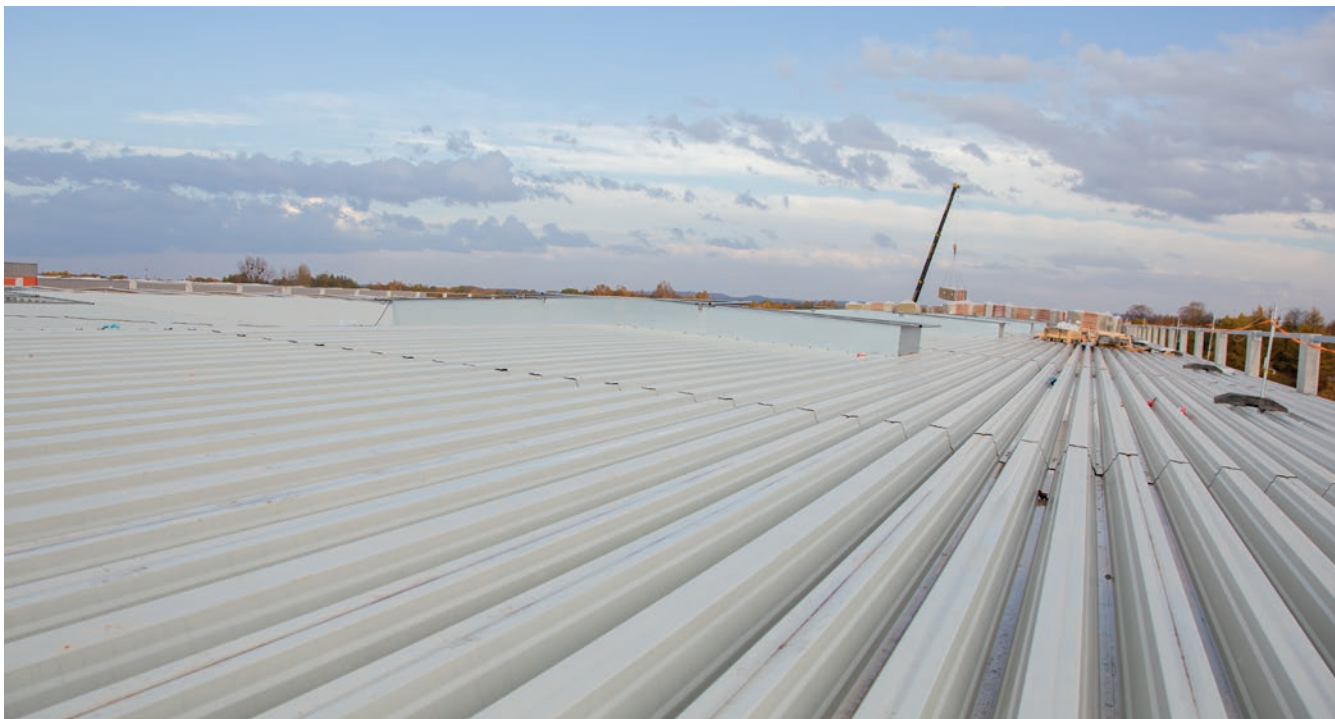
Szycie blach na zakład
