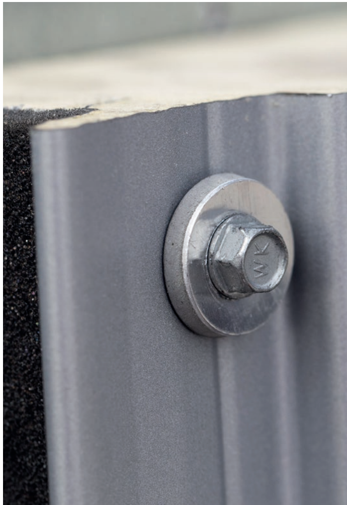
Zamocowana ścienna płyta warstwowa do stalowej podkonstrukcji
