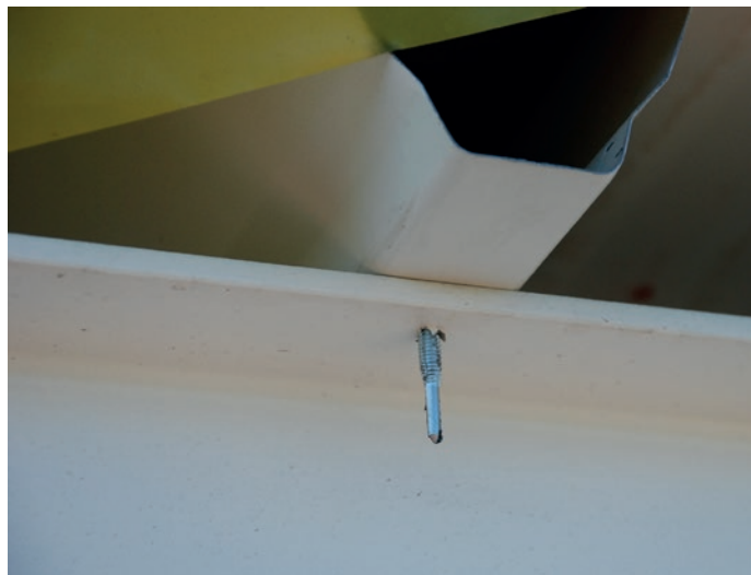
Zamocowana blacha trapezowana do konstrukcji nośnej dachu
