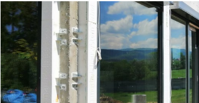
Zamocowania w technologii ciepłego montażu
