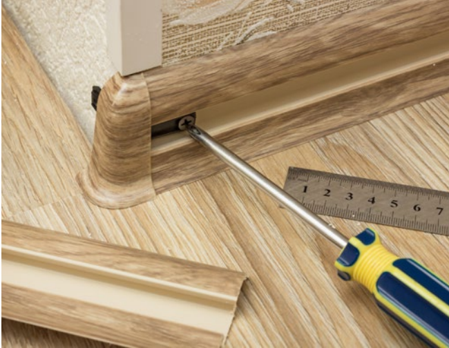
Montaż listew przypodłogowych
