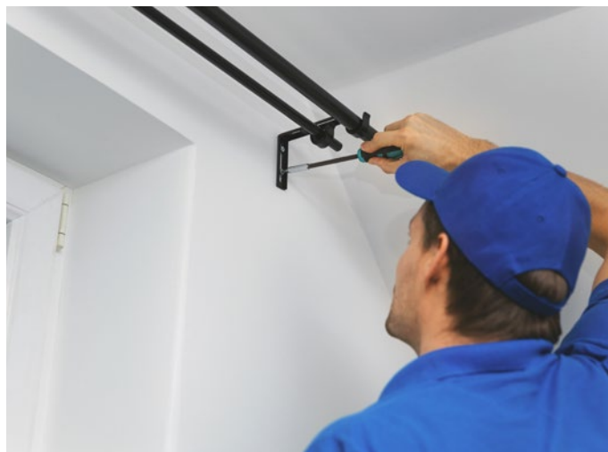
Montaż karniszy w podłozach gipsowych
