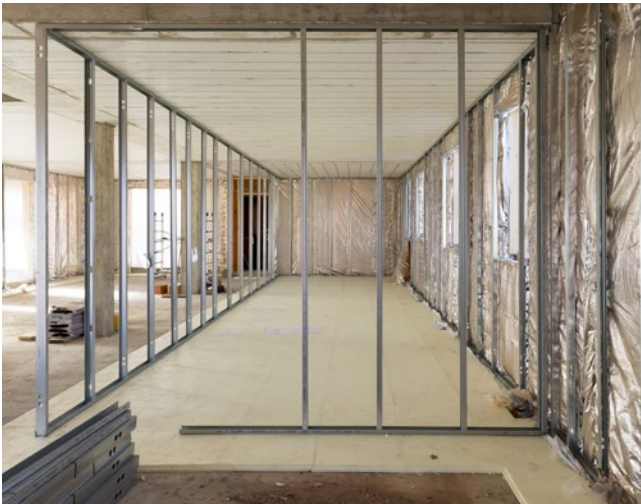
Montaż profili ścian z płyt GK
