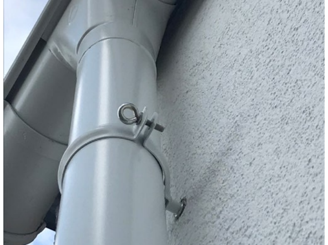
Montaż obejm w systemach rynnowych
