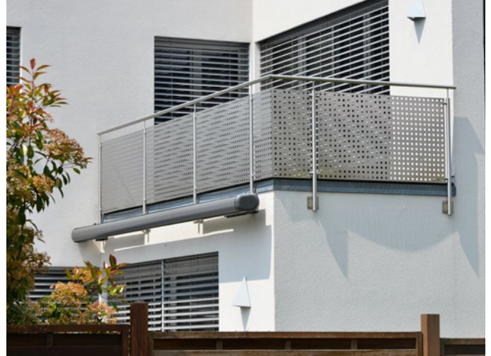
Montaż opierzeń w tarasach
