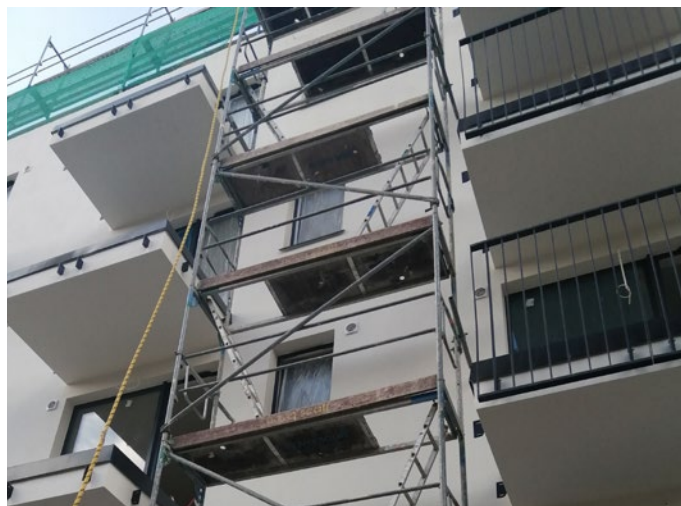
Montaż rusztowań przy wykonywaniu ociepleń ścian
