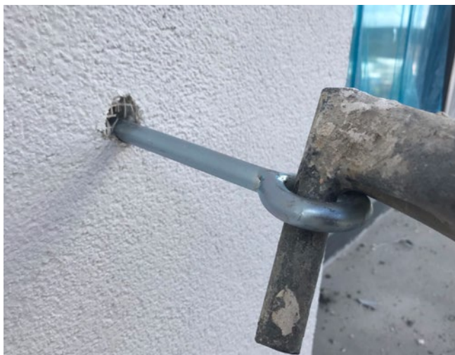
Montaż rusztowań podczas montażu elewacji wentylowanych
