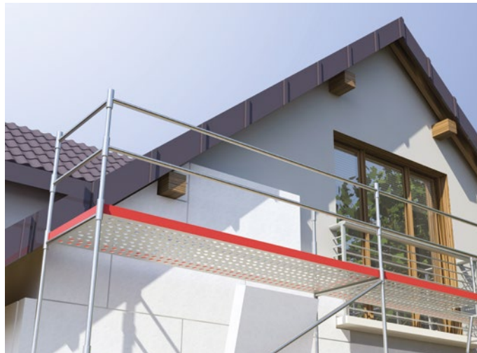
Montaż rusztowań w budynkach jednorodzinnych
