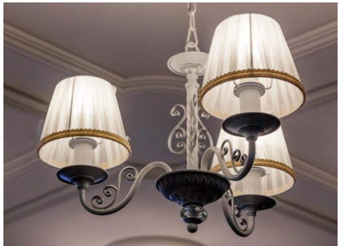
Montaż typowego oświetlenia sufitowego
