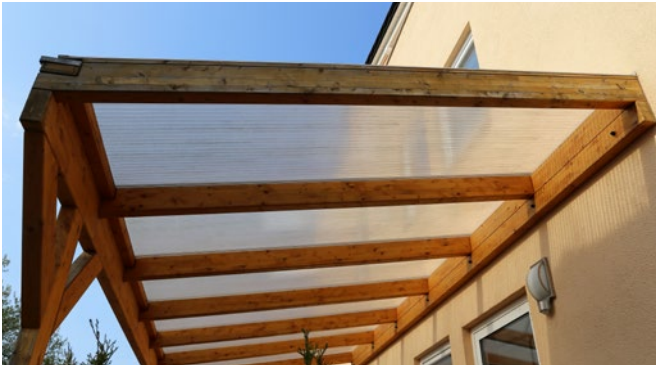
Montaż konstrukcji drewnianych
