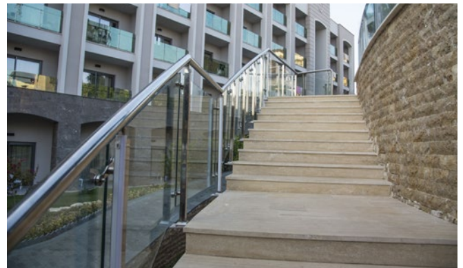
Mocowanie elementów instalacji budowlanych
