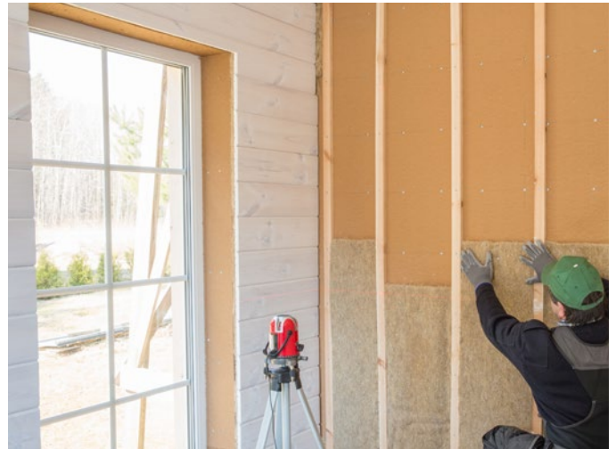
Montaż konstrukcji drewnianej ścianek działowych
