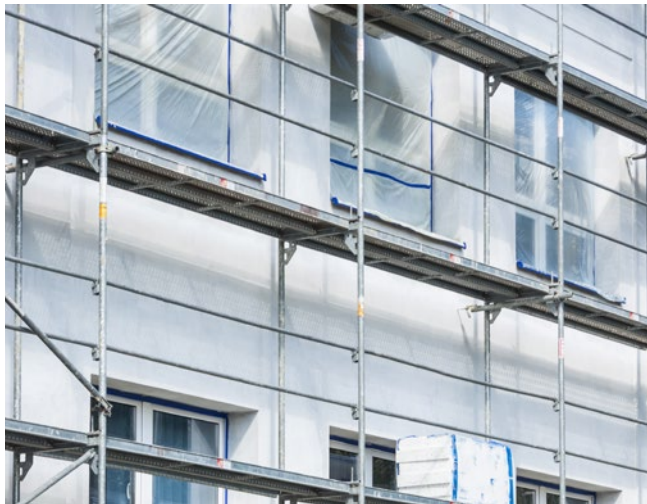
Montaż rusztowań w budownictwie wielorodzinnym
