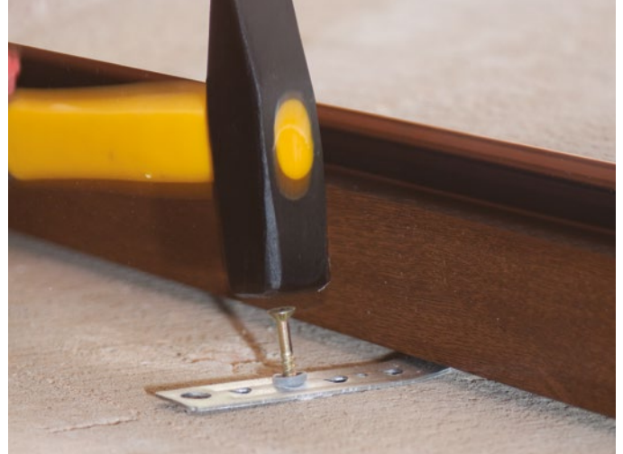
Montaż profili przy pomocy łączników
