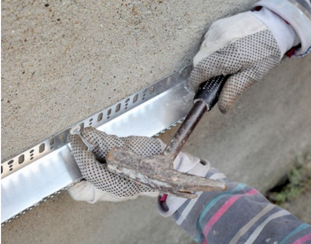
Montaż profili listew startowych
