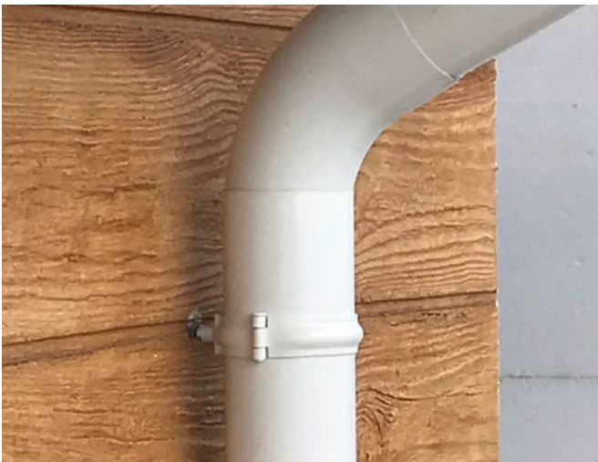
Montaż obejm w systemach rynnowych
