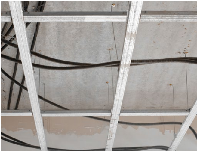
Montaż profili przyściennych w sufitach kasetonowych
