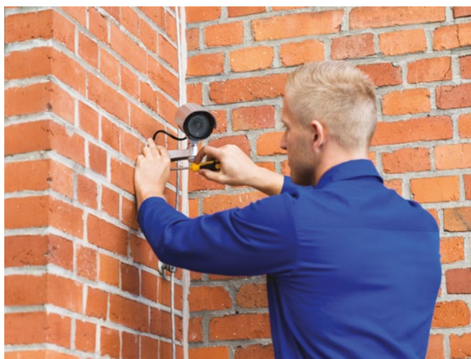
Montaż elementów monitoringu na ścianach z cegieł
