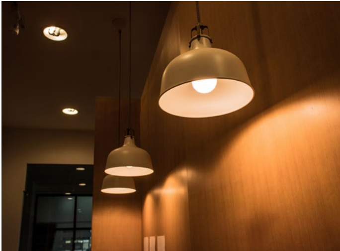
Montaż typowego oświetlenia sufitowego
