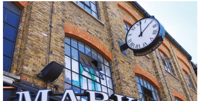
Mocowanie elementów instalacji budowlanych
