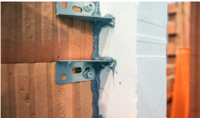
Mocowanie w technologii „ciepłego montażu”
