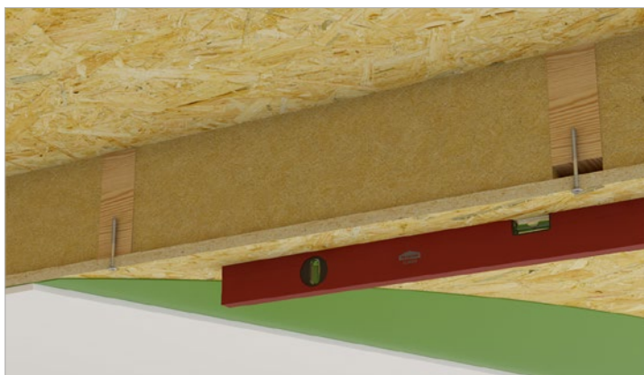
Poziomowanie powierzchni sufitów
