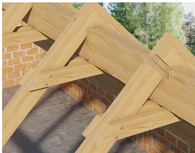
Montaż więźby dachowej
