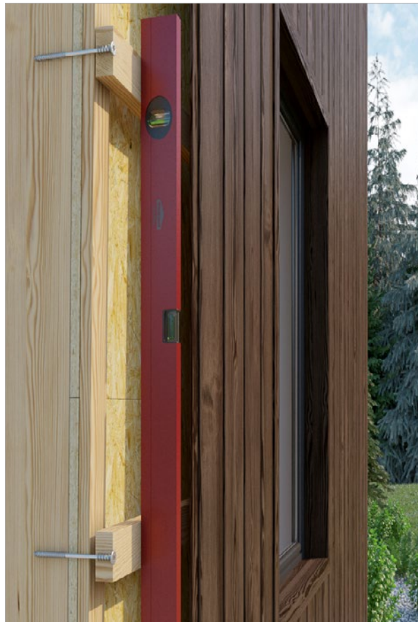
Poziomowanie elewacji zewnętrznej
