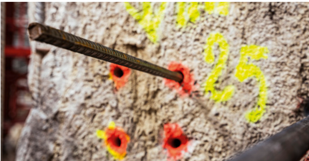
Ein nachträglich eingemörtelter Bewehrungsstab auf einer Baustelle.
