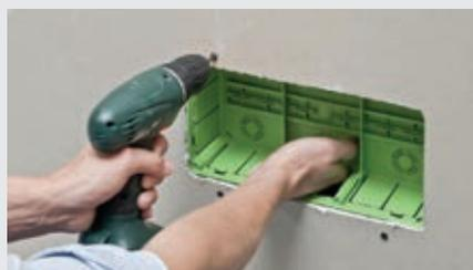
Le alette di fissaggio presenti sui contenitori permettono il fissaggio sull'orditura metallica o sulla lastra. Le griffe delle scatole per serie civili permettono l'installazione sulle lastre. I centri di fissaggio permettono invece il montaggio a parete in caso di ristrutturazione.
