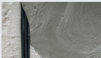
I tubi FK-Xtreme, grazie alla particolare conformazione a doppia parete, garantiscono una protezione totale alla penetrazione delle componenti liquide del cemento. Il rivestimento esterno offre una resistenza supplementare in cantiere contro calpestii, schiacciamenti e urti anche alle basse temperature (fino a -25°C).
