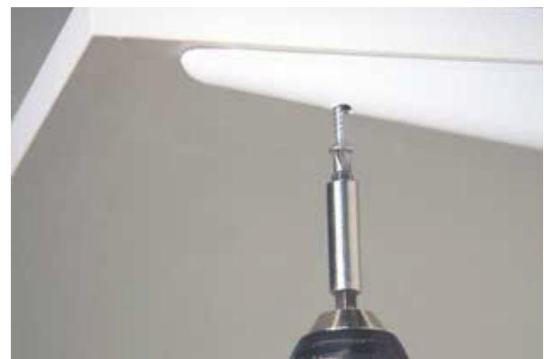
Kiinnitä levyhylly kannattimen läpi ruuvilla.
