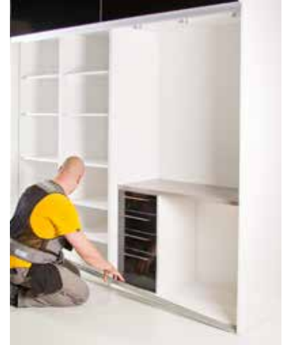
Alakiskon voi kiinnittää liimamassalla tai kaksipuoleisella teipillä. Alakisko kiinnitetään päätylevyjen etureunan kanssa samaan syvyyteen.
