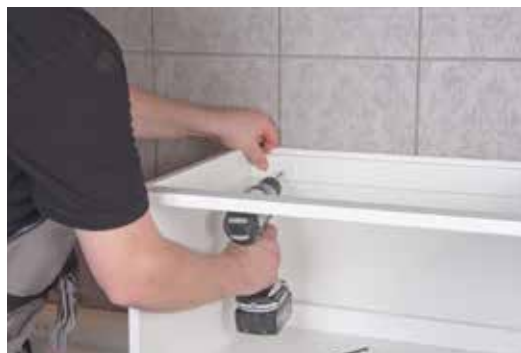
Kiinnitä asennushela (ASKULMANS) sidelistaan.
