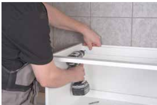
Merkitse seinäankiinnitysruuvien paikat sidelistaan. Tarkasta kiinnityskorkeus.
