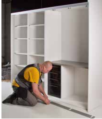
Kuvassa alakiskoon kiinnitetään kaksipuoleista teippiä.
