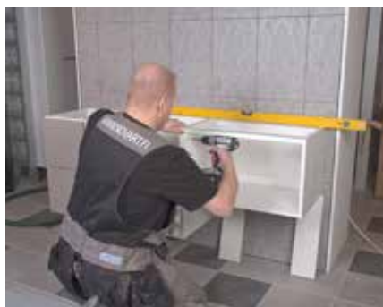
Kiinnitä rungot toisiinsa.
