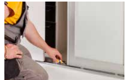
Tee lopullinen korkeus- ja kallistussäätö oven sivusta.
