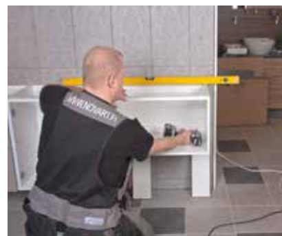
Kiinnitä rungot alaselälistasta seinään.
