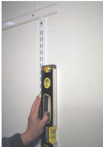
Asemoi pystyprofiili oikeaan paikkaan. Tarkista pystysuoruus ja kiinnitä seinämateriaalin mukaisilla ruuveilla.
