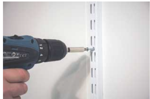
Kiinnitä pystyprofiilit seinään seinämateriaalin mukaisilla ruuveilla. Kiinnitysten tiheys kiskossa seinämateriaalin ja varustelun mukaisesti.
