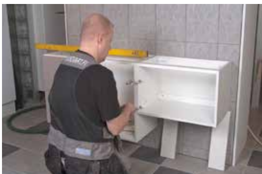
Tue viereinen kaappi. Kytke rungot toisiinsa puristimia apuna käyttäen.
