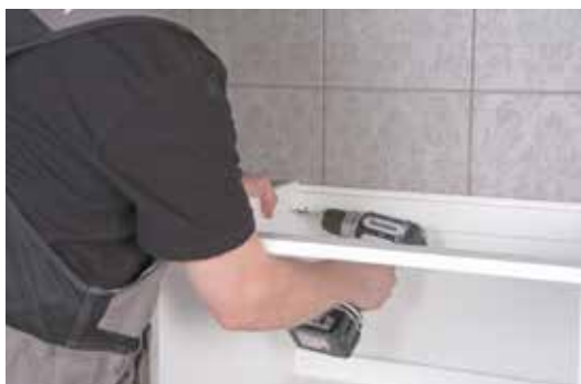
Kiinnitä asennushela (ASKULMANS) kaapin sivuun.
