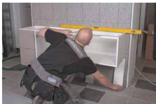
Tue viereinen kaappi. Kytke rungot toisiinsa puristimia apuna käyttäen.
