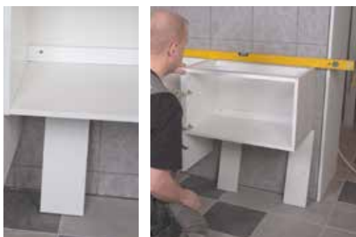
Tue kaappi oikeaan korkoon. Tarkasta suoruus (syvyys- ja leveysuunnassa) ja kiinnitä seinään.
