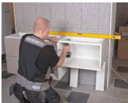
Kiinnitä rungot yläsidelistasta seinään.
