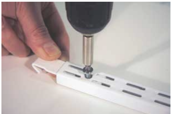
Ripustinkoukun kiinnitys pystyprofiiliin.
