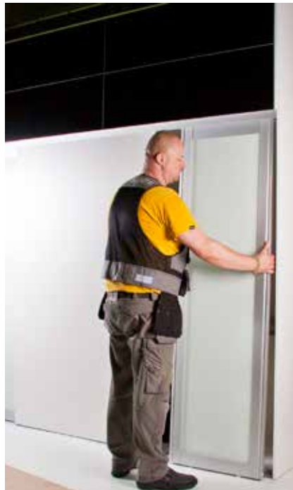
Nosta ovi paikoilleen, ensin yläkiskojen väliin ja sen jälkeen laske pyörästä alakiskoon.
