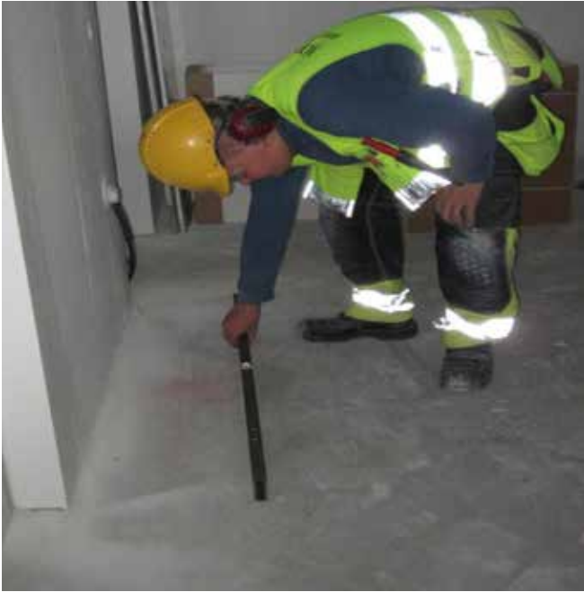
Asennus aloitetaan tarkistamalla lattioiden, seinien ja nurkkien suoruus.
