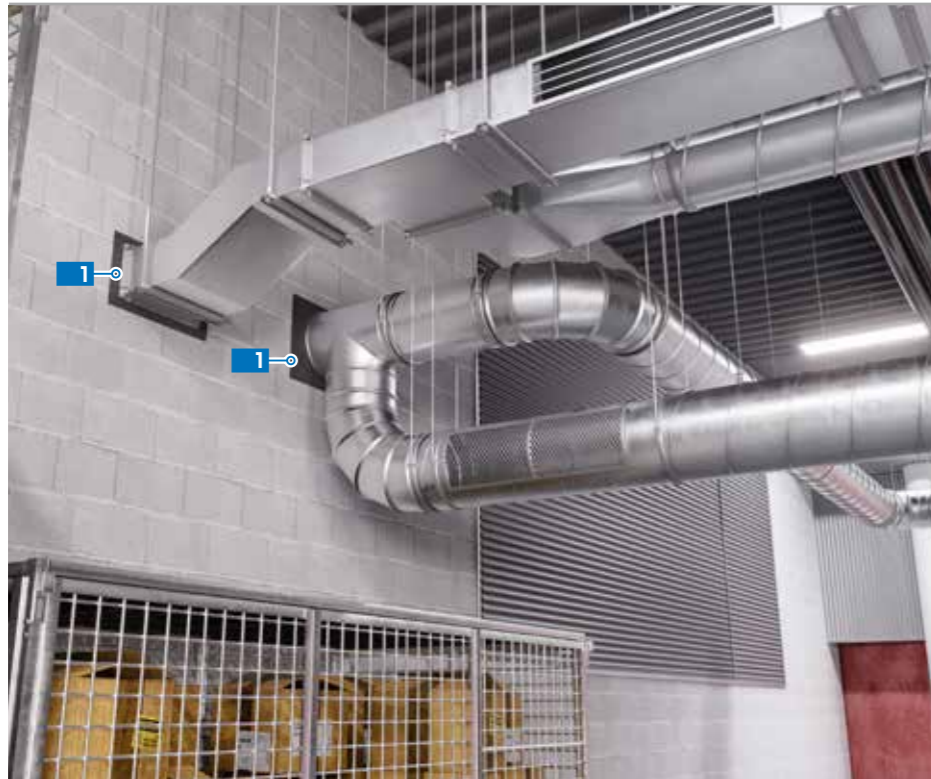
1 Schiuma poliuretana auto-espandente resistente al fuoco MAPEPUR FIRE FOAM M
