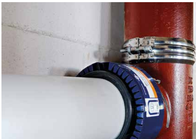
Curafam® KonfixPro nach dem Einbau auf der Baustelle
