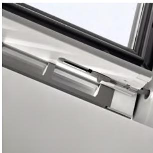
**1** Das Dachfenster kann um 180° gedreht und mit Hilfe des **VELUX Putzriegels** für eine einfache Reinigung von innen festgestellt werden.
