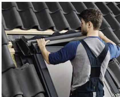
1. Ziegel über dem Dachfenster abdecken und das Eindeckrahmen-Oberteil entfernen.
