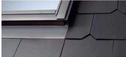
**EL 6000F Schiefer Schichtstück, wärmegeklämmt, EL 1000 Schiefer Schichtstück**
