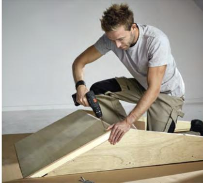
1. Die im Lieferumfang enthaltenen Dämmteile montieren.
