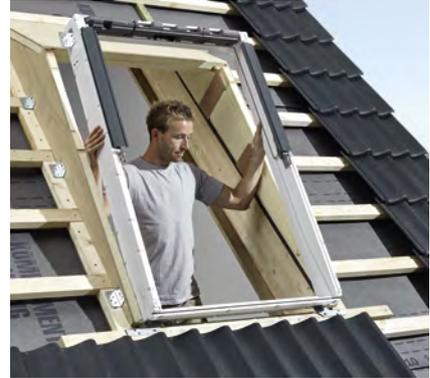
3. Fenster-Blendrahmen in die Dämmung einsetzen und verschrauben.
