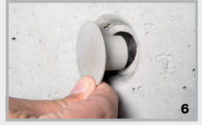
Nach dem Tiefsetzen des STOPPER in lässt sich ein Konus einkleben.
