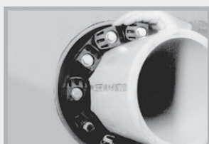
MASTER-SEAL in den Ringspalt einschieben
