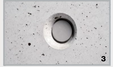
Verschluss Mauerstärke mit Konus
