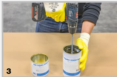
3 Die Mischung für mind. 2 Minuten aufrühren.
