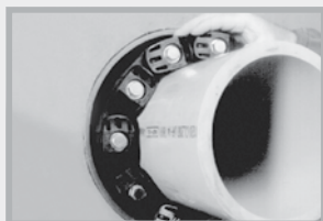
MASTER-SEAL in den Ringspalt einschieben
