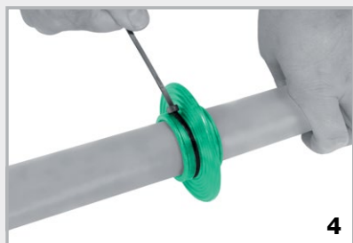
Festes Anziehen der beiden Spannbänder von Hand
