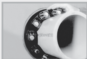
MASTER-SEAL in den Ringspalt einschieben
