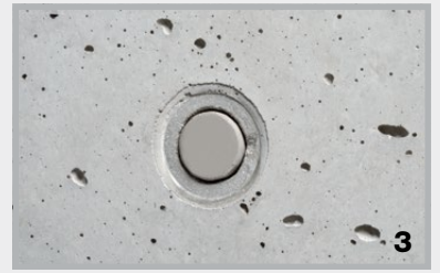
Bündiger Verschluss bei Mauerstärken mit Dichtlippe.
