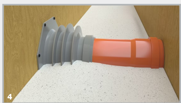
4 Betonage und sorgfältige Verdichtung
