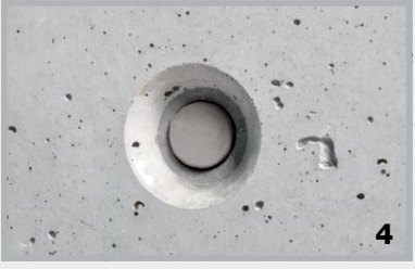
Bündiger Verschluss bei Mauerstärken mit Konus.
