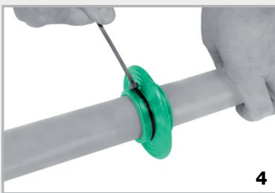
Festes Anziehen der beiden Spannbänder von Hand
