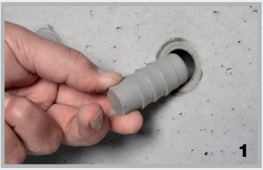
Der STOPPER in wird in die Mauerstärke gedrückt.
