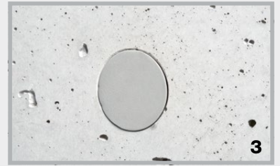
Druckdichter und oberflächenbündiger Verschluss
