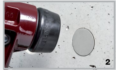
Einschlagen mit dem Gummihammer
