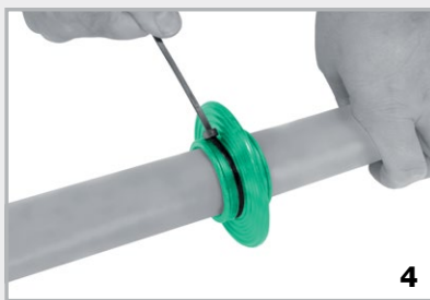
Festes Anziehen der beiden Spannbänder von Hand
